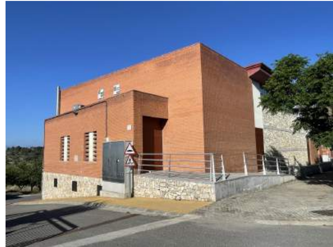
Imatge 03 : Sala Polivalent de Bellaguarda – Façana lateral (est)
