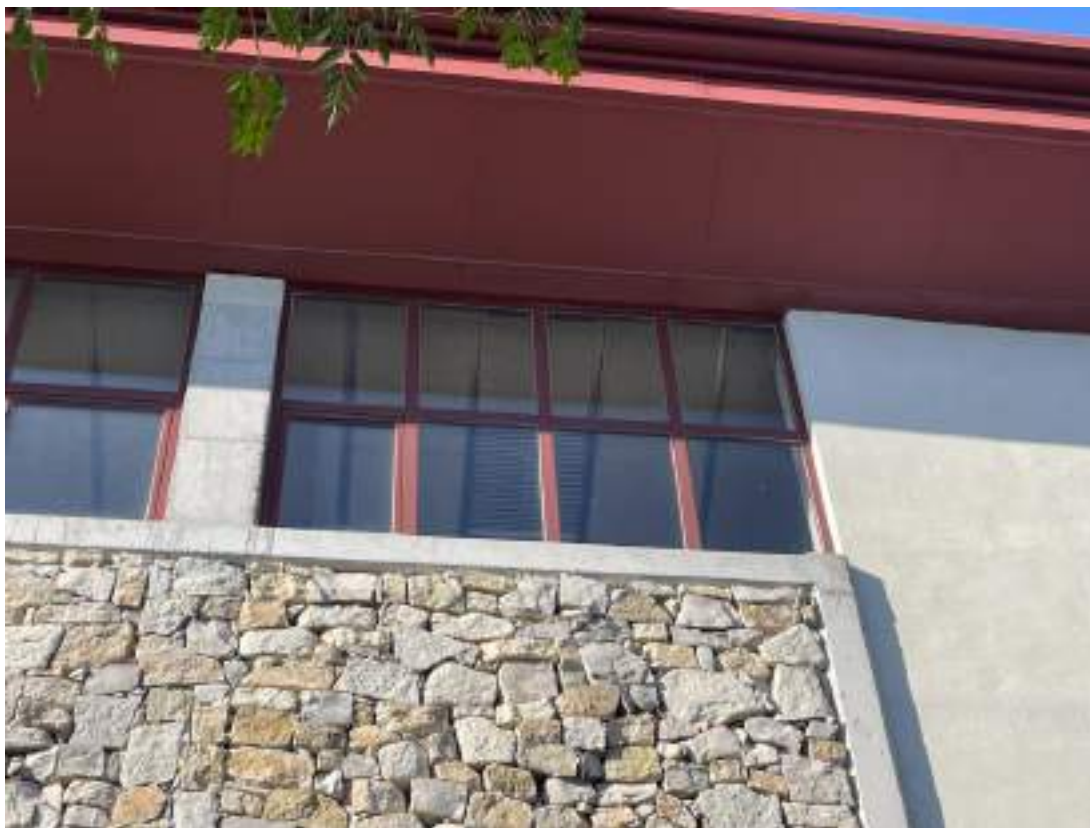
Imatge 06 : Finestres a substituir per unes de motoritzades segons projecte.
