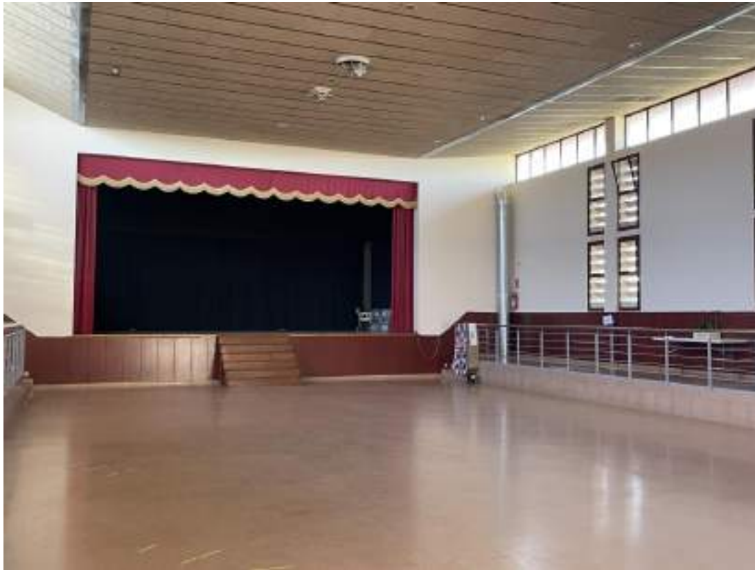
Imatge 05 : Interior de la sala polivalent – Escenari principal i tub de l'obrador a encaixonar amb guix laminat.
