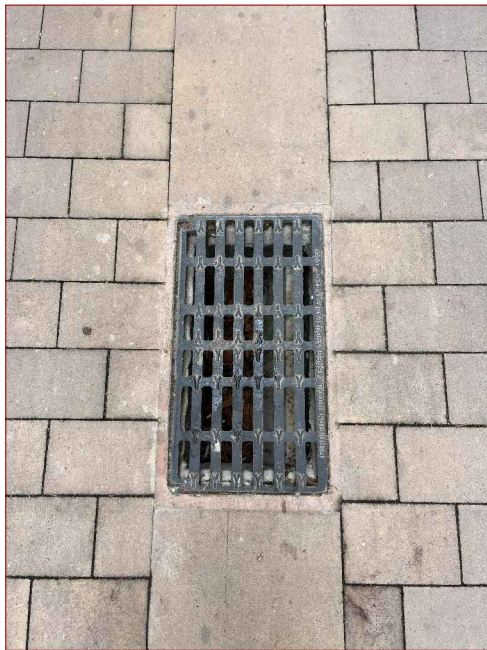
IMATGE – DETALL EMBORNAL INTEGRAT EN PAVIMENT
