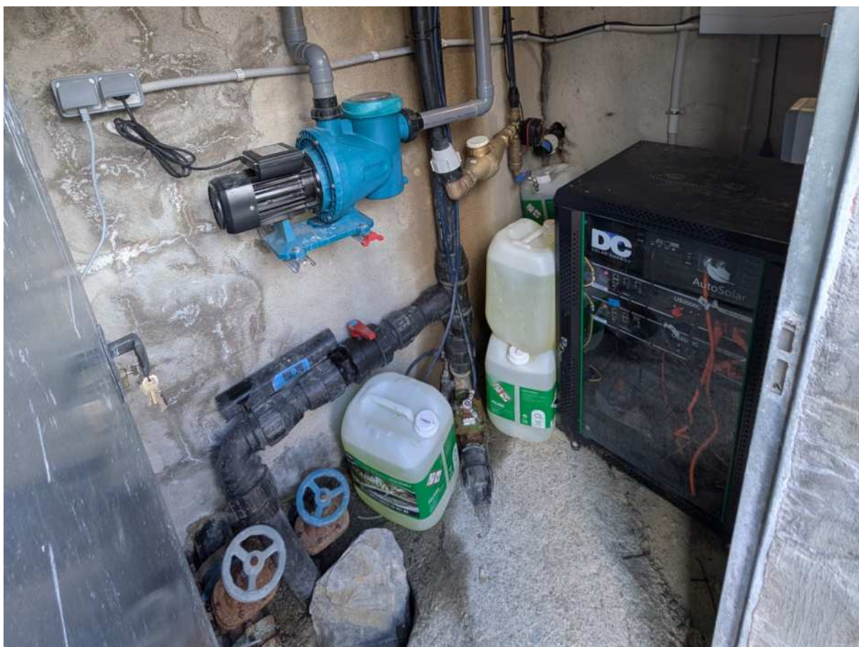
Xarxa Lladrós - caseta dipòsit
