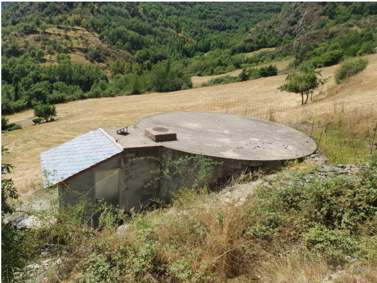
Xarxa Estaon - dipòsit
