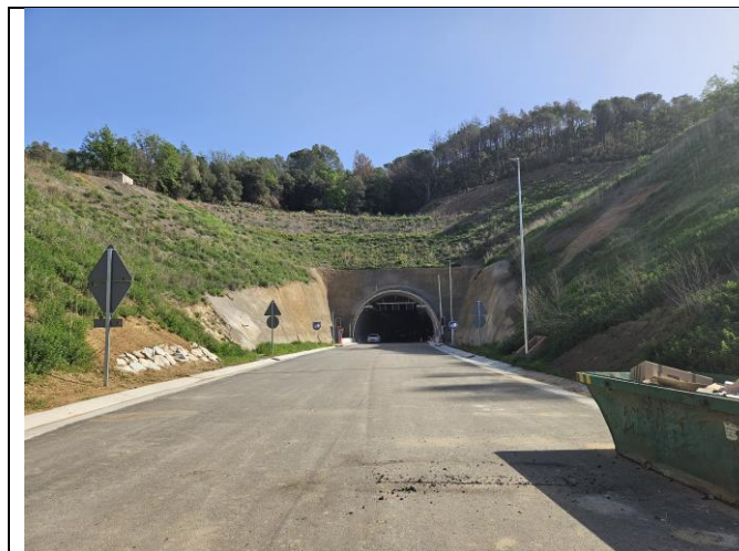
Talussos en desmunt de més de 3 m a la boca sud del túnel on s'han d'aplicar plantacions d'arbres i arbustos, així com planta enfiladissa a les parts més inclinades, per a la seva integració ambiental i paisatgística
