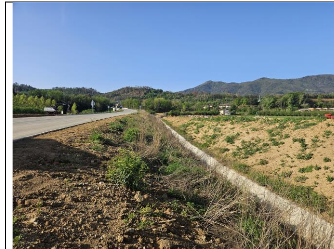
Talussos en terraplè de menys de 3 m amb recobrint herbaci desigual després de les hidrosembres aplicades en el marc del projecte
