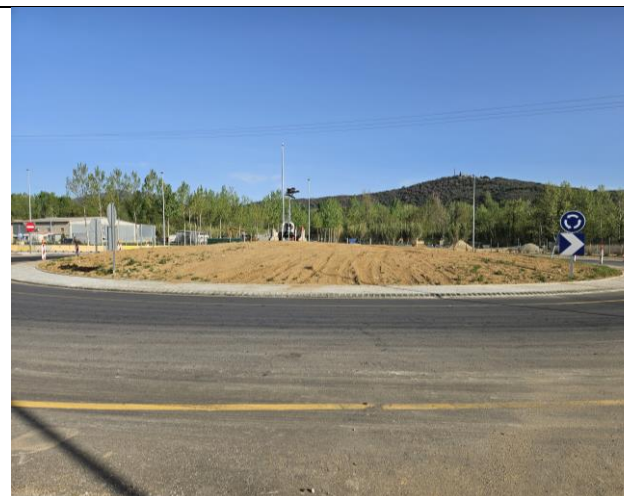
Vista en sentit E des de la rotonda nord d'enllaç amb la N-141e.
