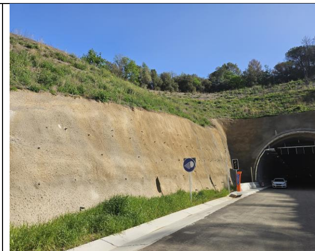
Talussos en desmunt a la boca sud del túnel a recobrir amb planta enfiladissa per a la seva integració ambiental i paisatgística
