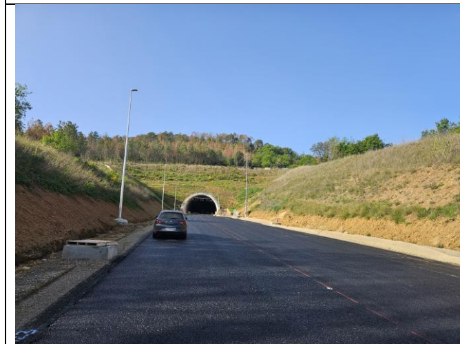
Talussos en desmunt de més de 3 m a la boca nord del túnel on s'han d'aplicar plantacions d'arbres i arbustos, per a la seva integració ambiental i paisatgística
