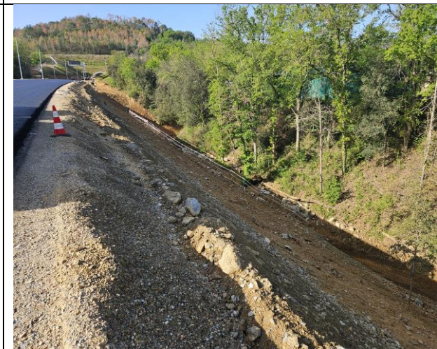
Talussos en terraplè de més de 3 m i canalització del rec de Ca n'Aulet
