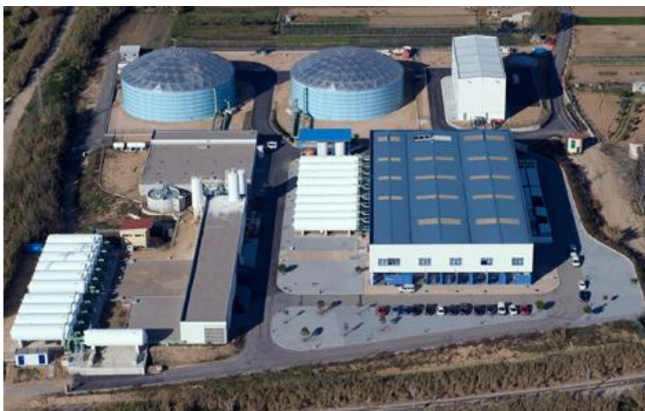
Planta dessalinitzadora ITAM Tordera (Google imatges)
