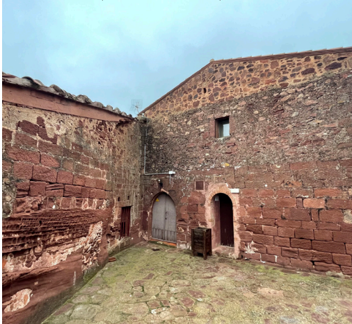
Vista V8: Vista de l'accés a l'àrea de dormitoris de la planta primera des de la façana nord.
