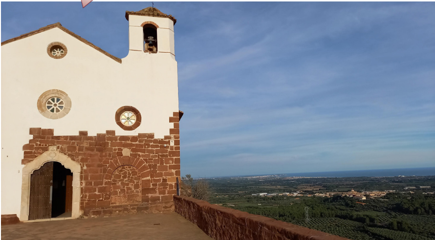
Vista V5: Façana principal Ermita Mare de Déu de la Roca.
