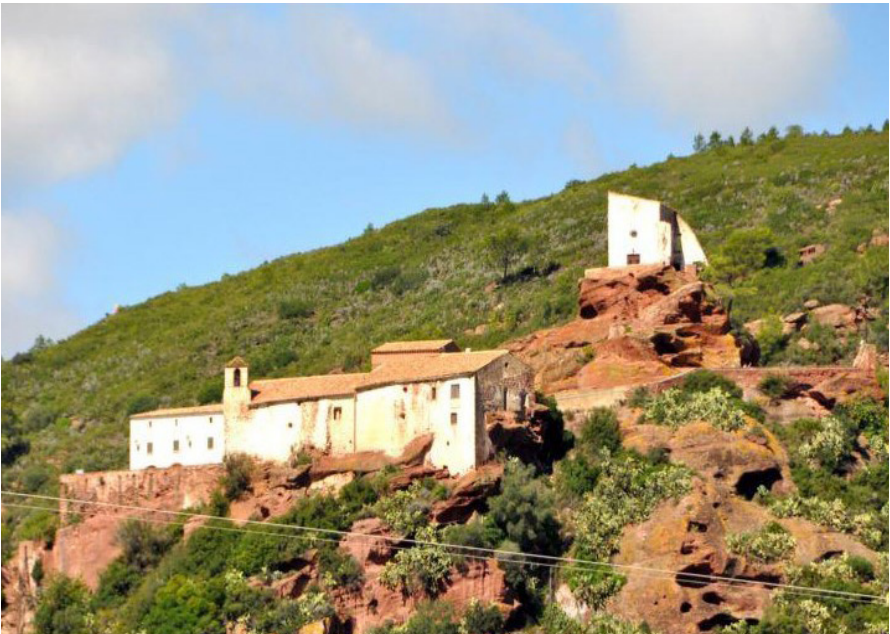
Vista V3: Façana sud. Vista aèria
