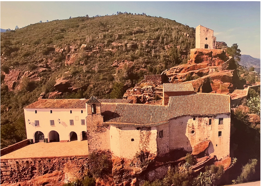
Vista V2: Façana sud. Vista aèria
