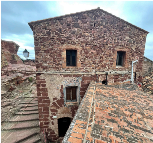
Vista V10: Façana oest del volum dels dormitoris.
