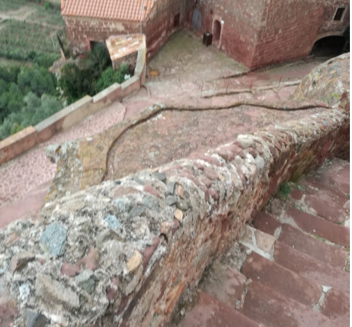
Vista V9: Canal de recollida d'aigües interior recinte
