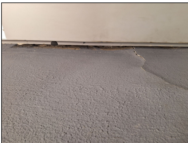
Foto 27: Escrostonaments sala control.
