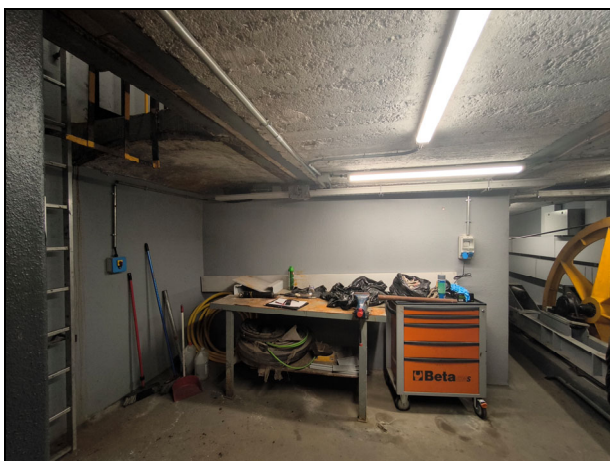
Foto 5: Vista forjat nivell inferior.
