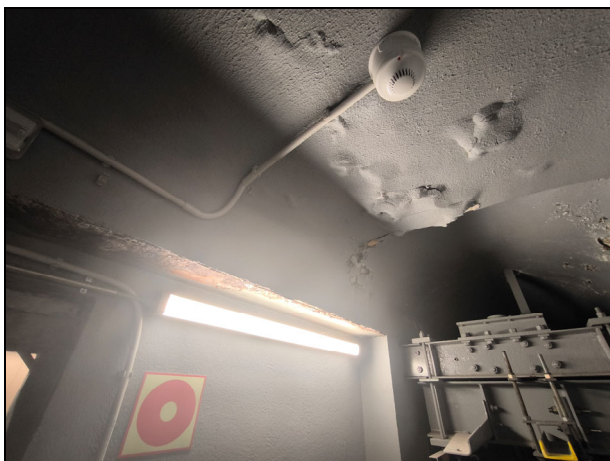
Foto 1: Volta nivell superior sala contrapesos.
