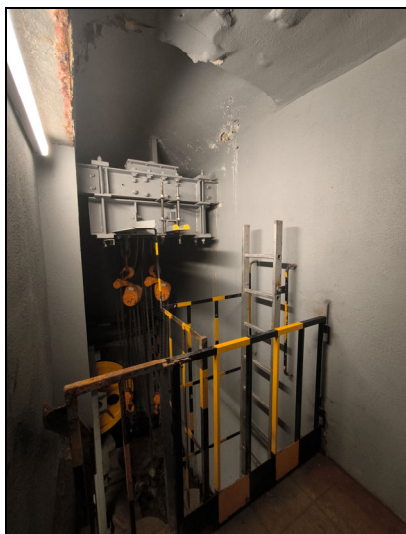
Foto 3: Vista de la porta i barana.
