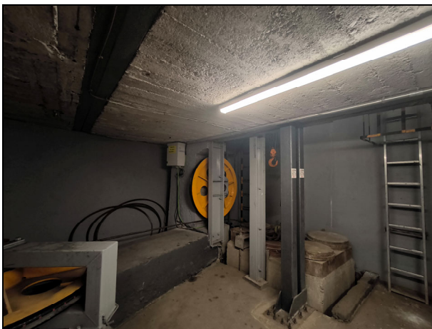
Foto 11: Vista del forjat del nivell inferior.
