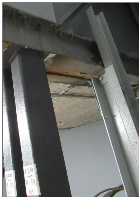
Foto 10: Detall pilars en perfecte estat.
