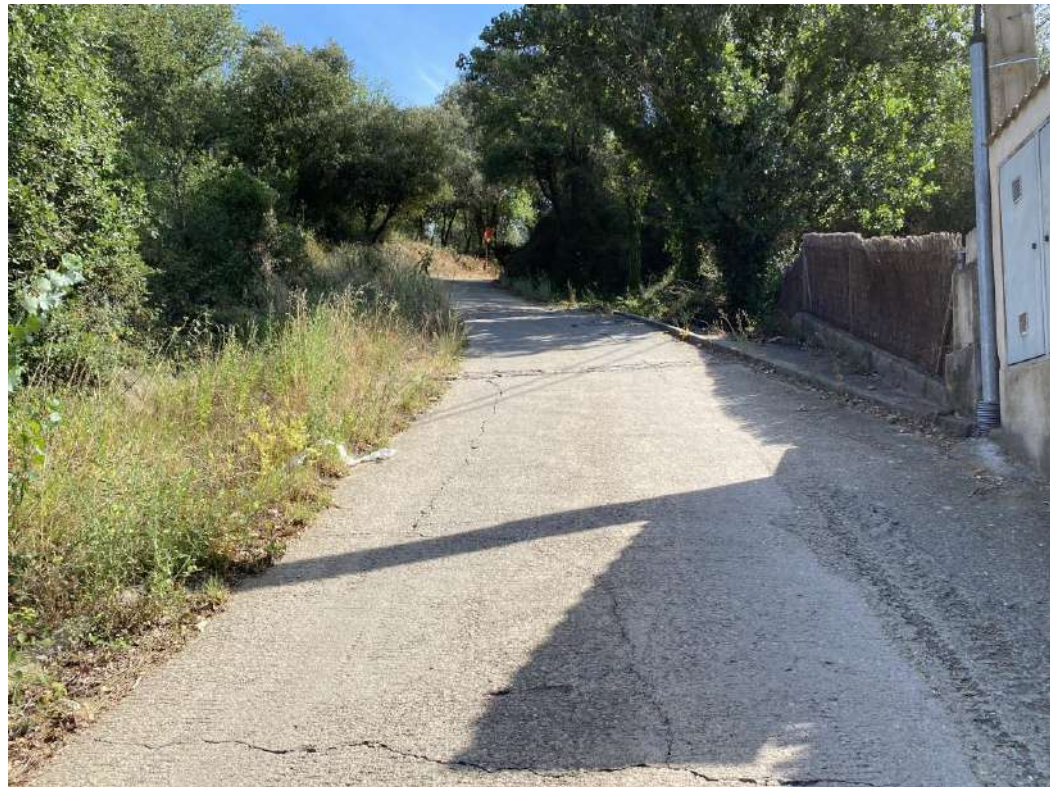
Imatge núm. 12. Detall del fort pendent existent al llarg del traçat del carril bici.
