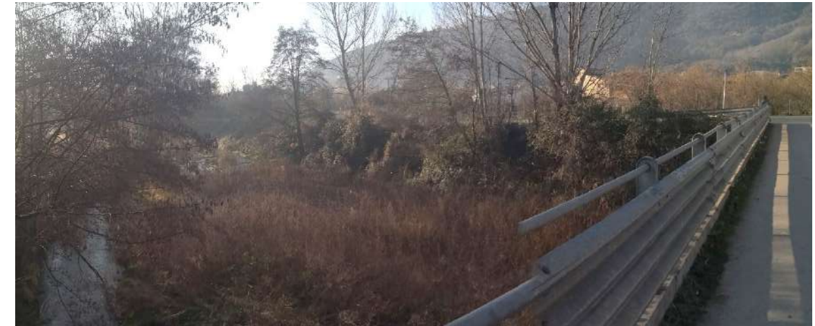
Fotografia 9: vista del Brugent riu avall del pont de Santa Brígida
