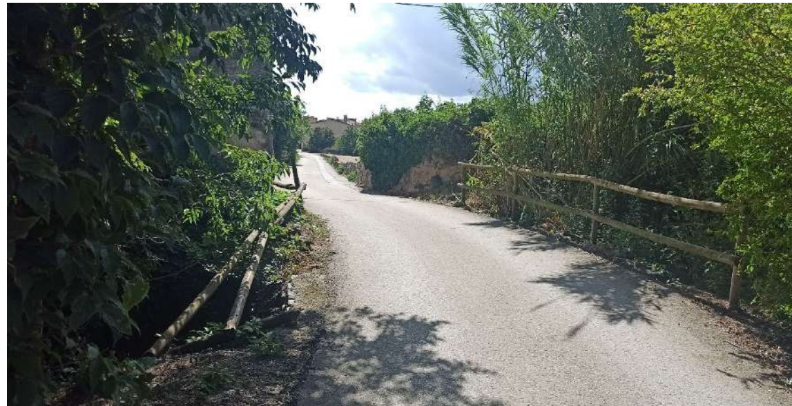
Fotografia 2: Barana de fusta a l'alçada del Gustet
