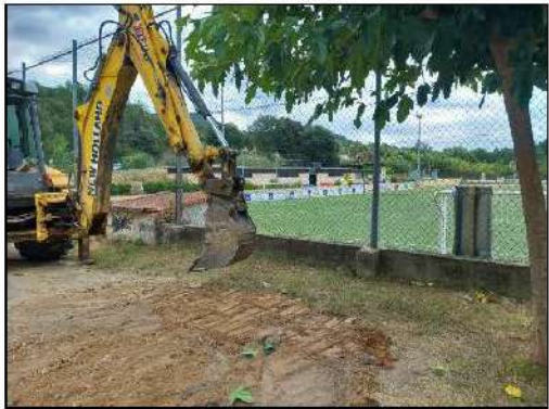
Figura 7. Máquina empleada para la ejecución de calicatas durante los trabajos realizados.
