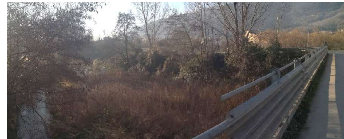
Fotografia 10: Vista del Brugent riu avall del pont de Santa Brígida
