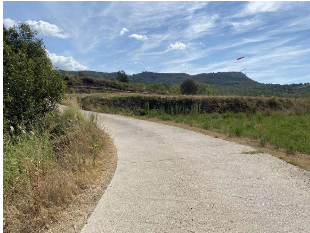
Imatge núm. 16. Vista del vial existent per on s'executarà el nou carril bici.
