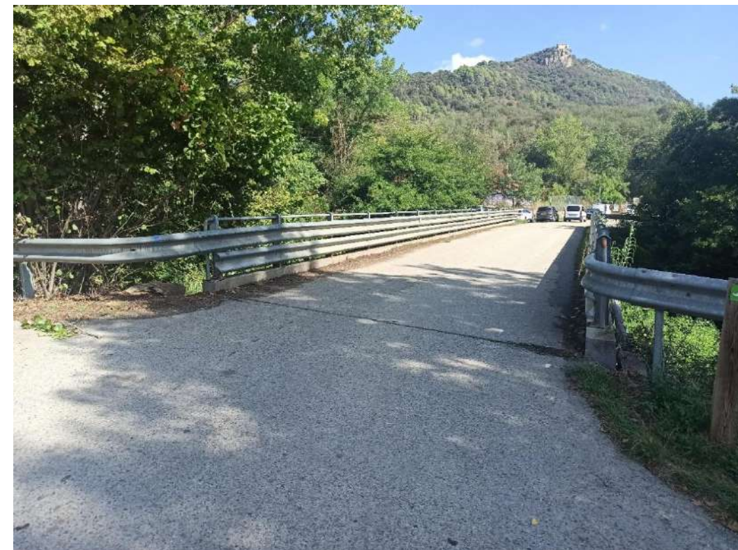
Imatge núm. 7. Vista passarel·la actual de creuament del riu Brugent
