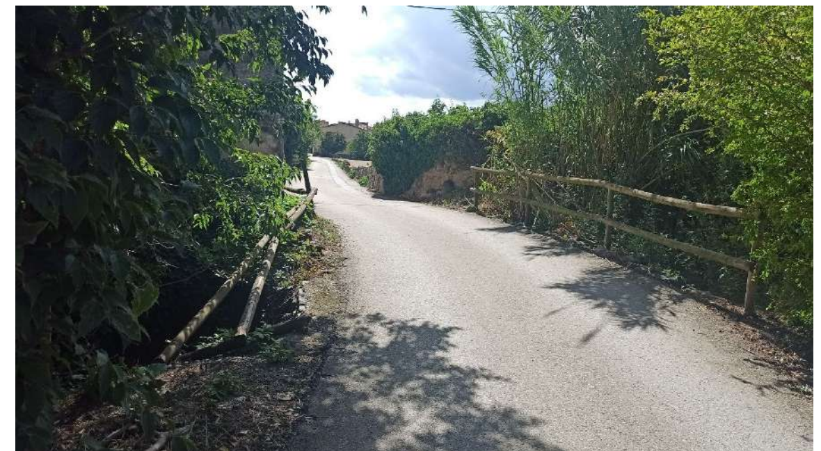
Fotografia 5: Barana de fusta a l'alçada del Gustet
