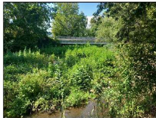
Figura 19. Vista de la pasarela actual en la zona de la conexión con el vecindario de Santa Brígida donde se observa el curso de agua del río Brugent.
