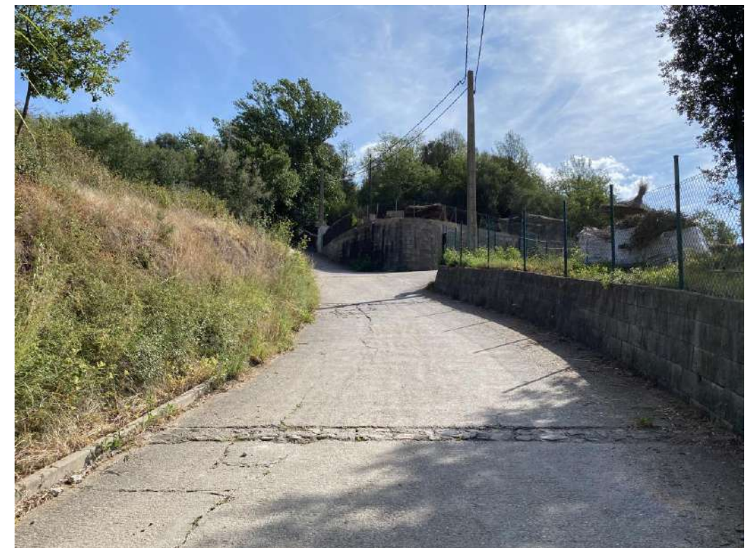
Imatge núm. 11. Detall de mur existent adjacent al camí de la Ruta de les Ermites.
