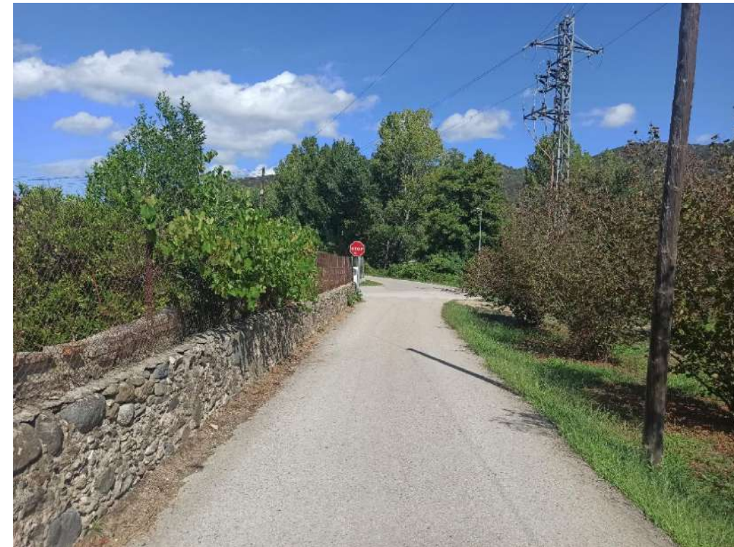
Imatge núm. 6. Detall de mur al recorregut del carril bici pel carrer del riu Brugent
