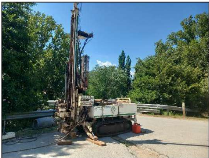
Figura 6. Maquinaria empleada para la ejecución de los sondeos.
