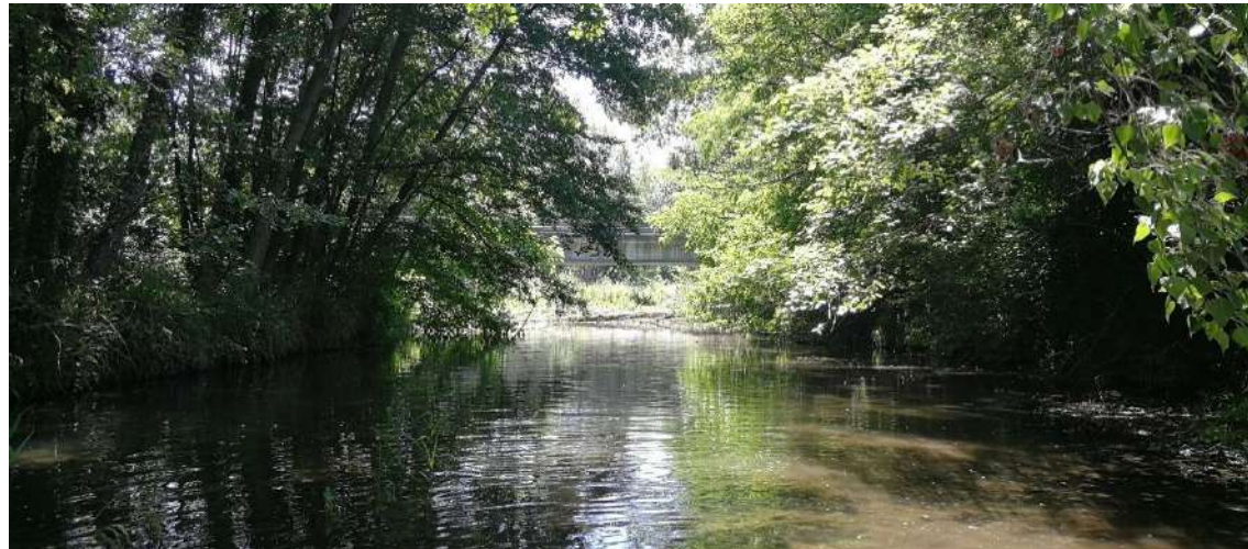
Fotografia 6: Pont de Santa Brígida (al fons) sobre el Brugent.
