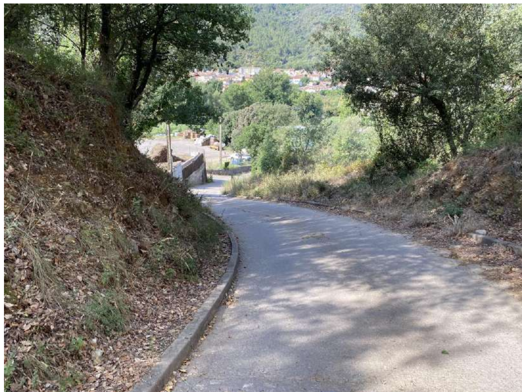
Imatge núm. 13. Vista del fort pendent existent al llarg del traçat del carril bici.
