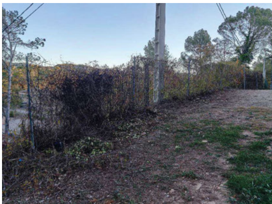
Figura 10. Tancament de protecció boca túnel de ferrocarril (final)
