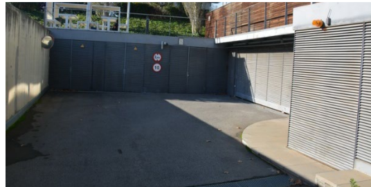
Imatge 22. Zona d'accés a l'aparcament subterrani REDESSA Cepid I.
