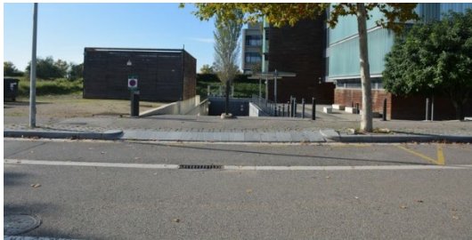
Imatge 21. Zona d'accés a l'aparcament subterrani REDESSA Cepid I.
