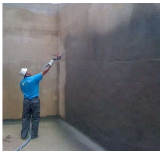
Figura núm.6 Aplicació de LOTUMCEM IMPERSTOP murs
