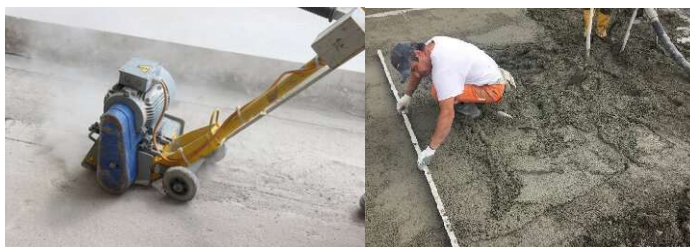
Figura núm.4 Fresat i formació de pendents posterior
