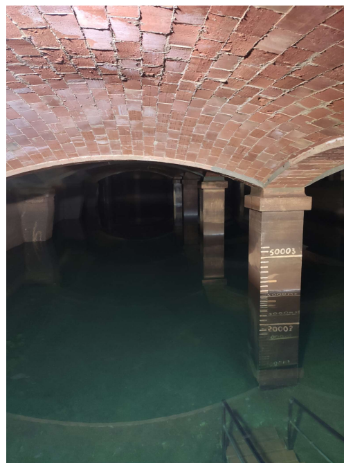
Foto Núm. 4 Sostre de volta catalana dipòsit d'aigua
