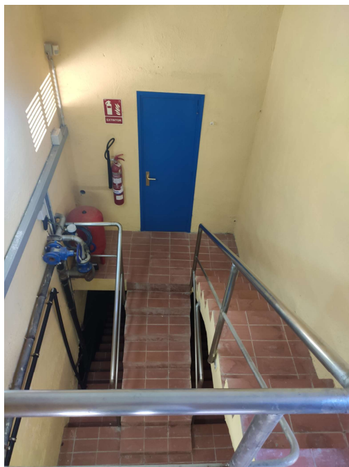
Foto Núm. 3 Escales accés a dipòsit
