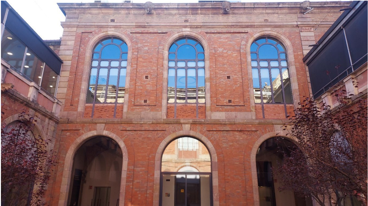
Ventanales FS-4, FS-5 y FS-6, del patio posterior sur, sustituidos en 2010
