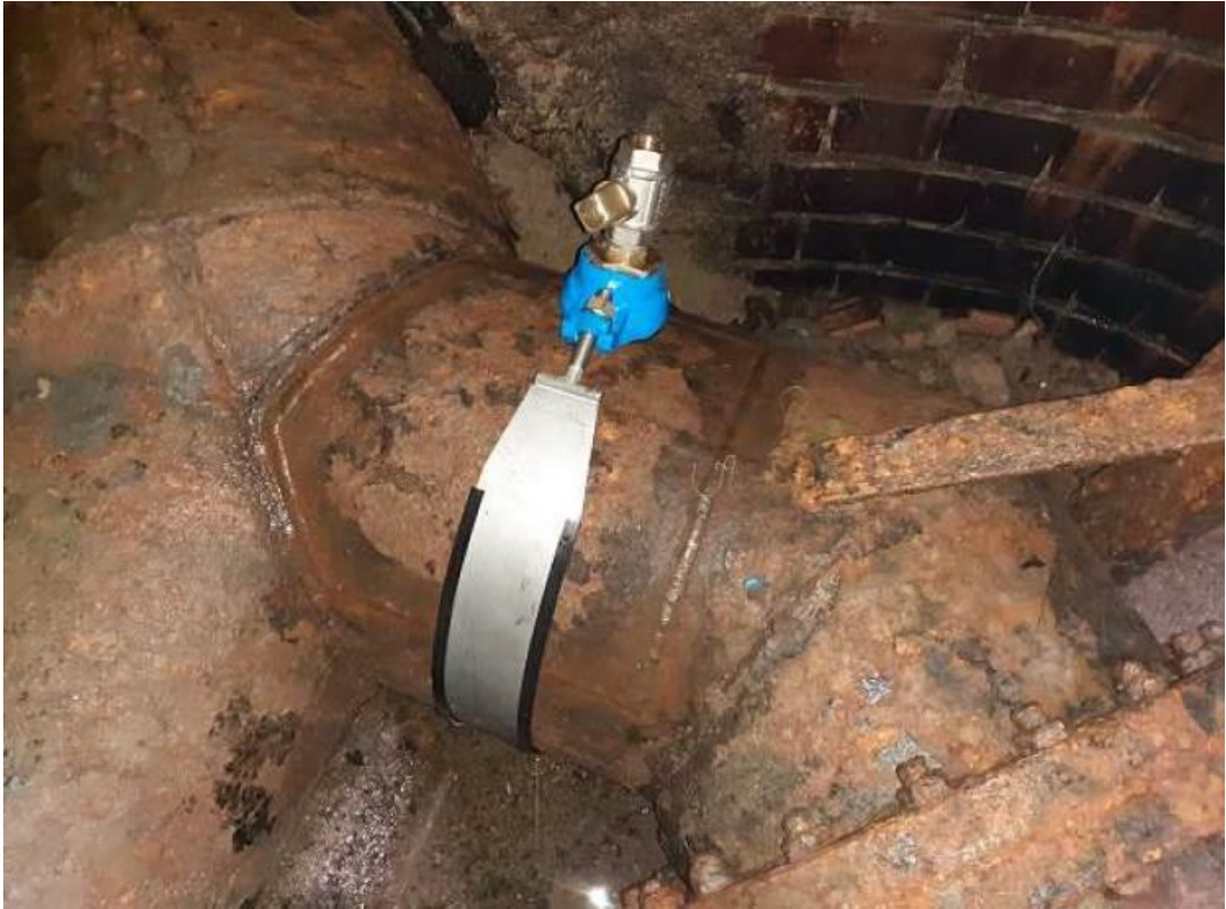
Figura 5. Punt de la canonada on es va produir la fuga, una vegada reparada.
