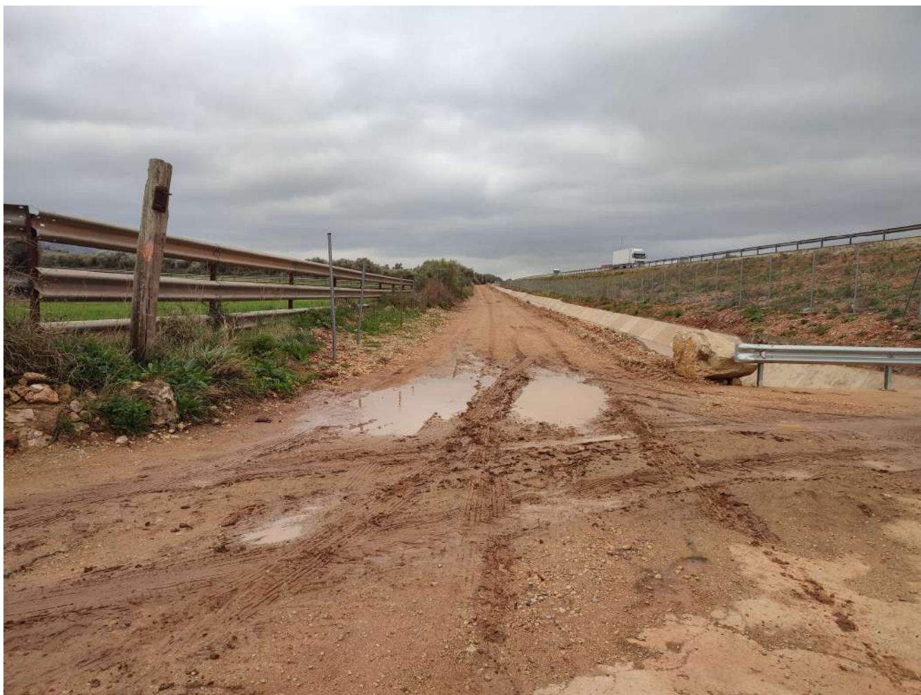
Vista tram 2 des de Pk: 1+816, final actuació
