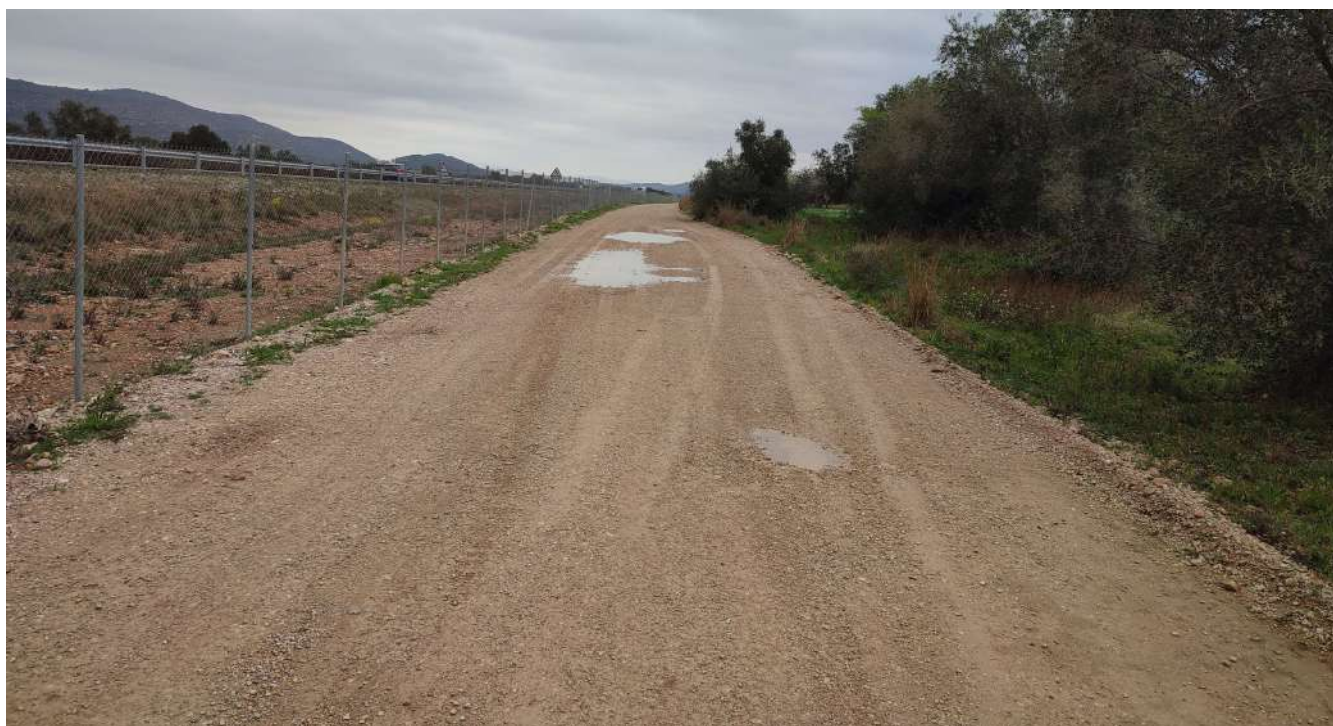
Vista general tram 1 entre Pk: 0+174 i 1+281, a pavimentar amb DTS
