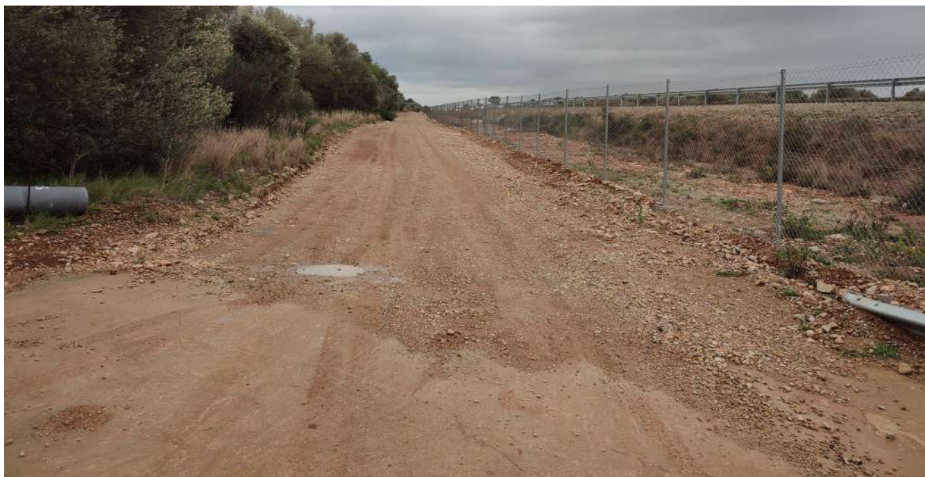
Vista tram 1 des de Pk: 1+281, a pavimentar amb DTS
