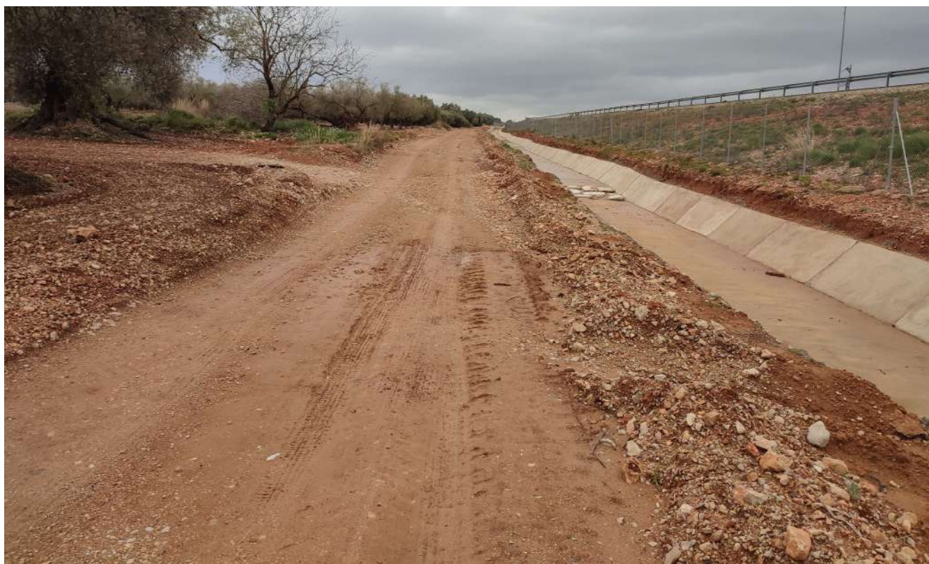
Vista tram 2 des de Pk: 1+580. Retirar cordo terres, rasanteig i compactació, aportació tot-ú i paviment amb DTS
