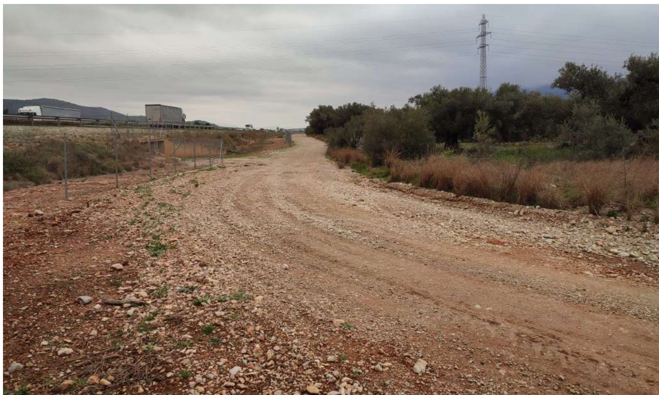
Tram Pk: 0+099 a 0+174, a pavimentar amb formigó
