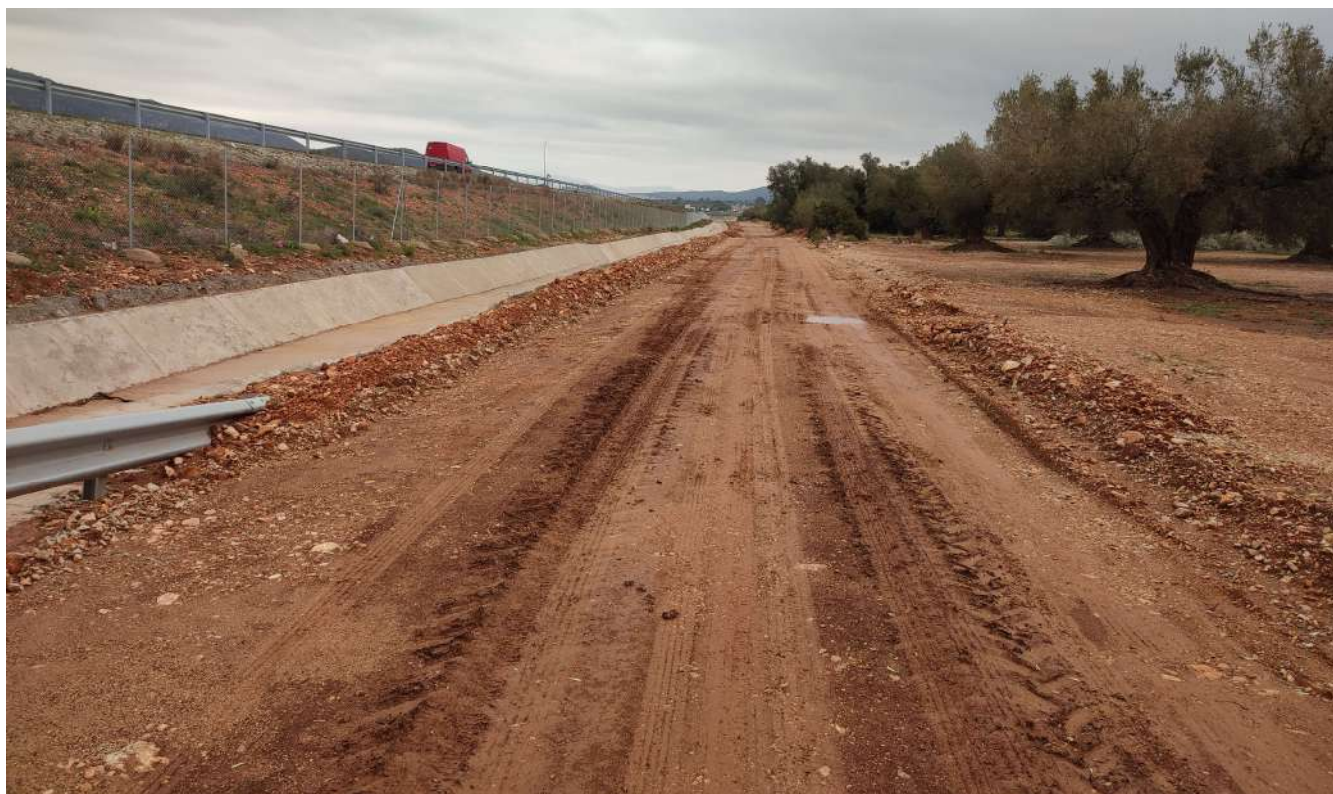
Vista tram 2 des de Pk: 1+310. Retirar cordo terres, rasanteig i compactació, aportació tot-ú i paviment amb DTS
