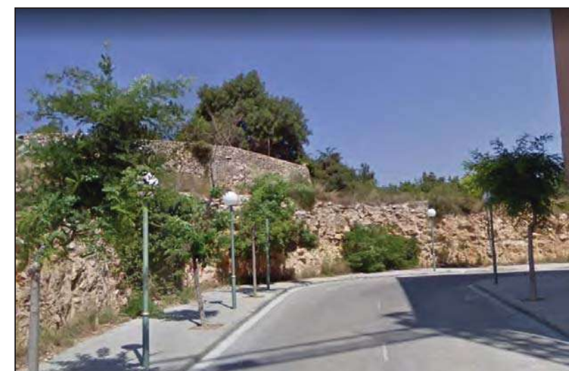
Fig. 8.-Vista dels talussos del substrat rocós a la part baixa del Polígon d'Actuació.
