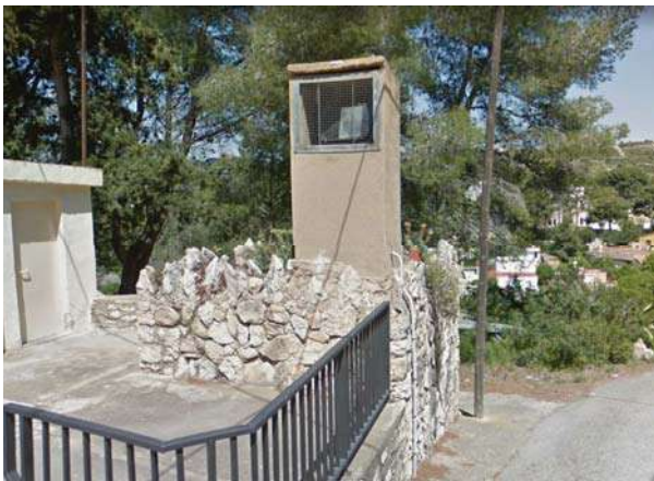
Fotografia peu de formigó a demolir.
