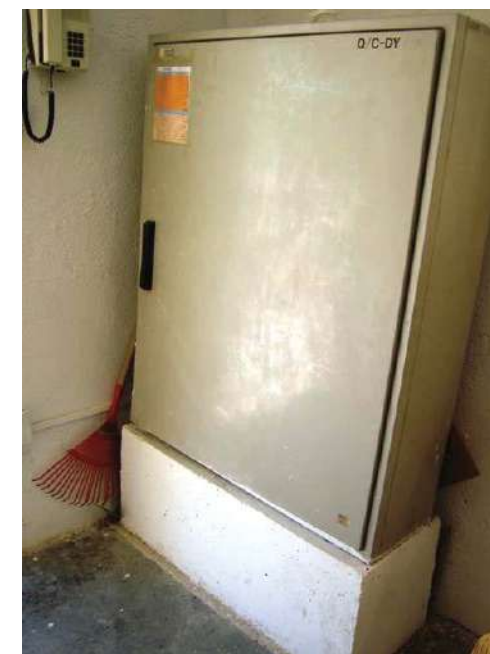
Fotografia quadre elèctric existent a enretirar i demolir.
