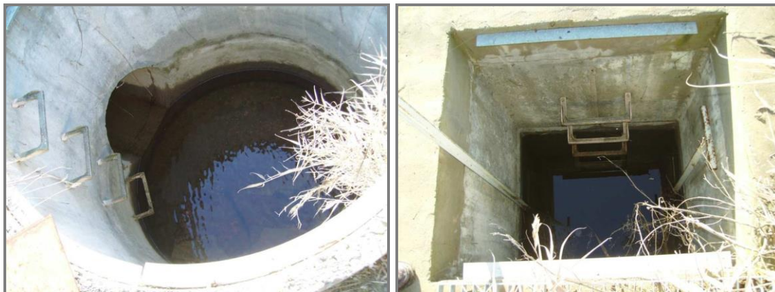
FIG 2. Vista general de la captació del Canal d'Urgell a Bellmunt d'Urgell i arqueta d'entrada a la Bassa de Terres.
