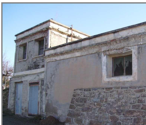
FIG 9. Caseta adossada al dipòsit vell.
