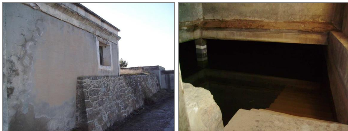
FIG 8. Vista general del dipòsit vell de Bellmunt d'Urgell i detall de l'accés al seu interior.
