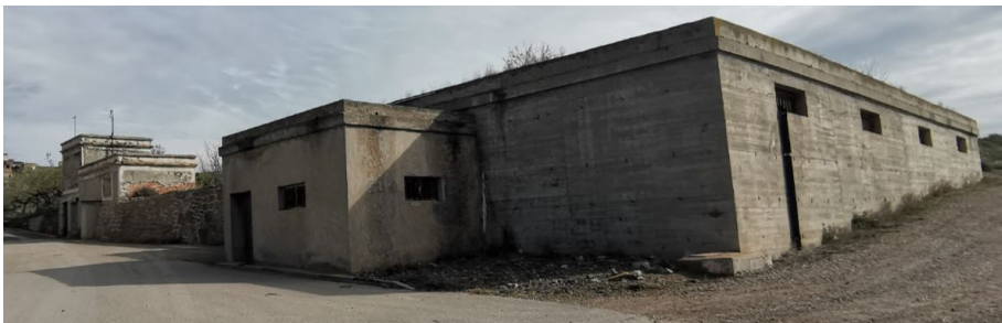
Edifici del dipòsit de recepció que alimenta a l'ETAP
