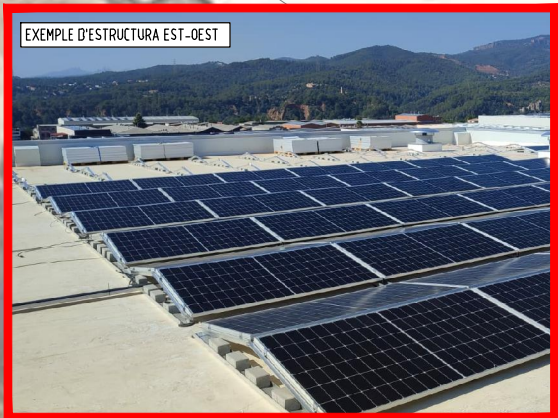
INSTAL·LACIÓ ESTRUCTURA EST-OEST SOBRE DIPÒSITS
