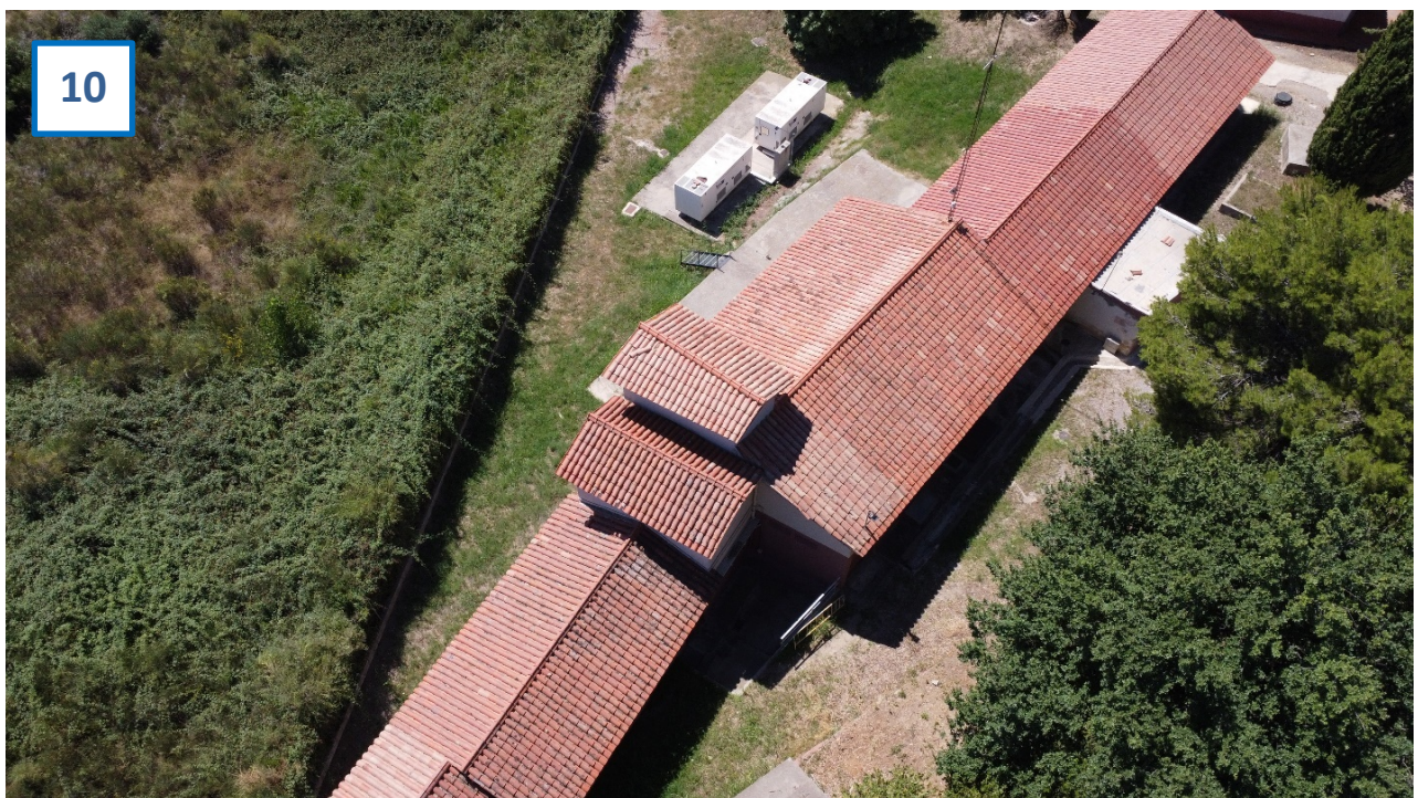
Imatge 10. Vista aèria del edifici al que s'alimenta
