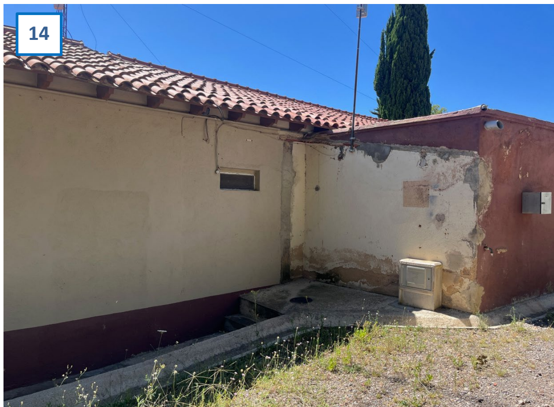
Imatge 14. Emplaçament dels inversors i quadres CA-CC
