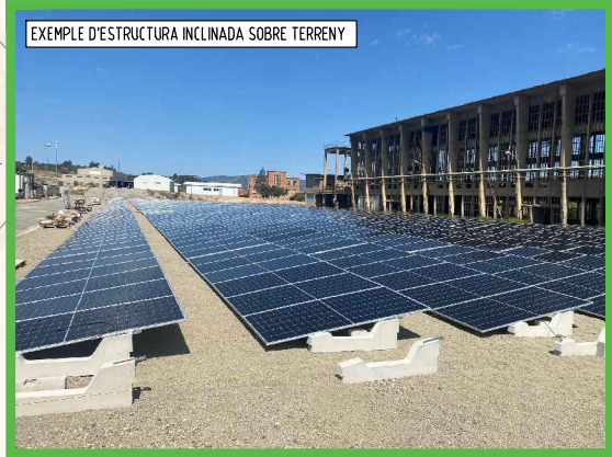
INSTAL·LACIÓ ESTRUCTURA INCLINADA SOBRE TERRENY
