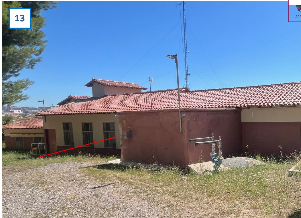
Imatge 13. Vista de de l'emplaçament dels inversors i quadres CA-CC
