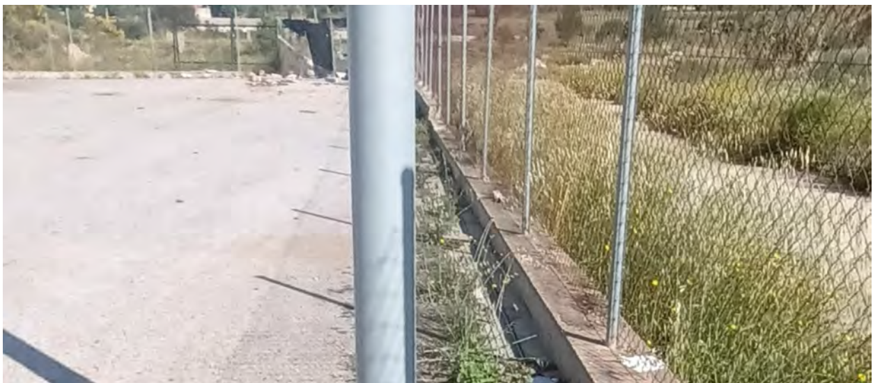
Mur, tanca i fanal a enderrocar.
