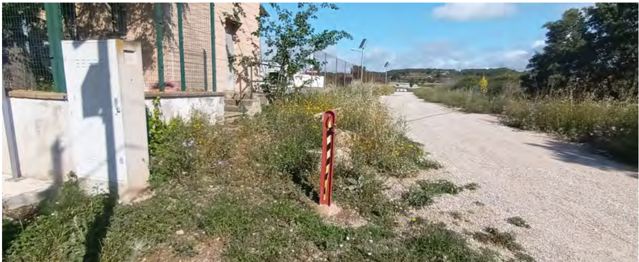
Zona a ampliar. Entrada.
