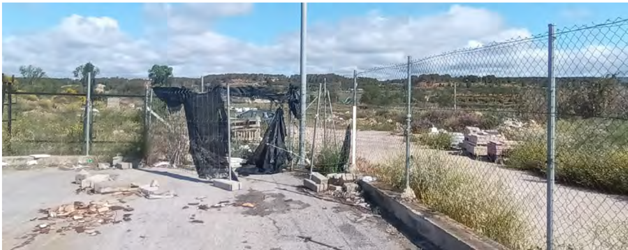
Zona a enderrocar per nous molls, inclòs fanal, mur, tancat, asfalt, etc.
