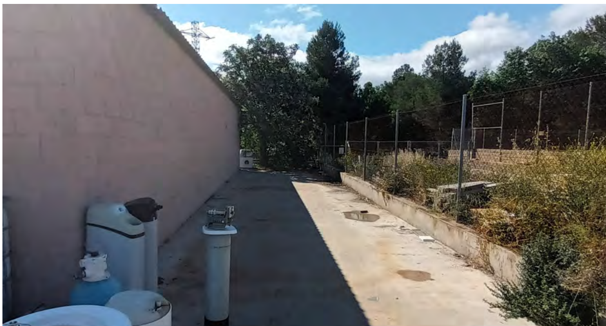
Zona on s'instal·larà la coberta metàl·lica.
