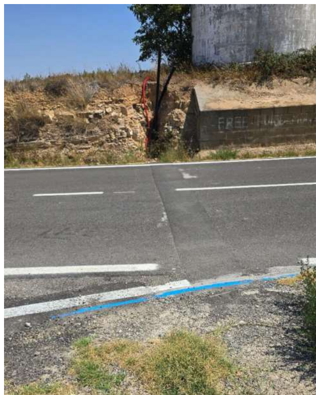
Figura 3. Creuament existent de la carretera L-214
