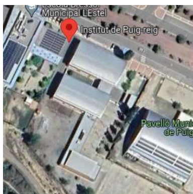
Figura 4 Edifici objecte d'obra fotovoltaica
