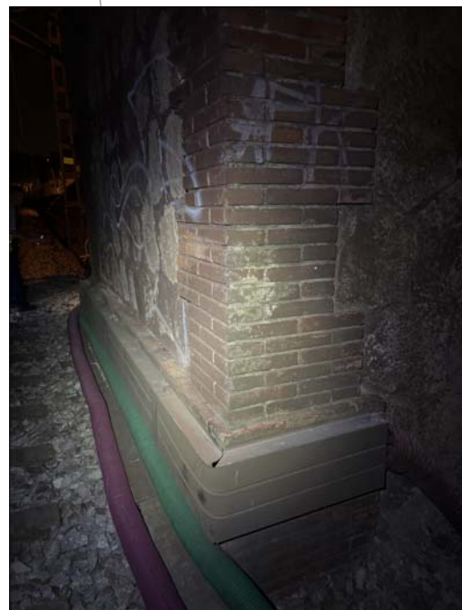
COL·LOCAR CABLES AMB PERXES SOTA PONT CARRER VESC
