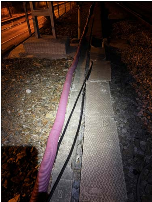
RETIRAR CANALS EXISTENTS I SUBSTITUIR-LES PER NOVES CANALS EN TOT EL RECORREGUT COL·LOCANT CABLES EXISTENTS AL SEU INTERIOR
