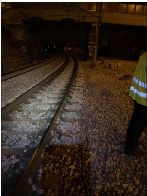
PRISMA FORMIGONAT EN ZONA ENTRADA VEHICLES VIA
