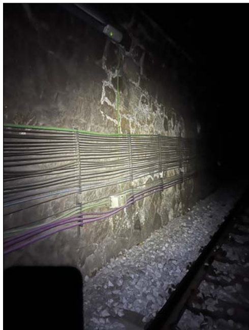
PENTINAR I ALEGIR FITXES PER CABLES CAIGUTS
