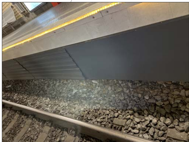
RETIRAR TANCAMENT SOTA ANDANA I COL·LOCAR PORXO
