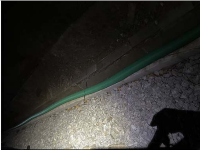
INSTAL·LAR CANAL PER CABLES SENYALITZACIÓ SOBRE MURET FIXADA I SANEJAR CANAL EXISTENT REPOSANT ALGUN TRAM CAIGUT
