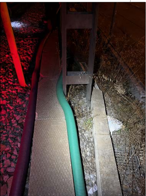
FORMIGONAR PRISMA AL VOLTANT DE PAL CATENÀRIA
