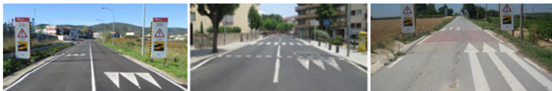
Plataforma reductora de velocitat en secció
