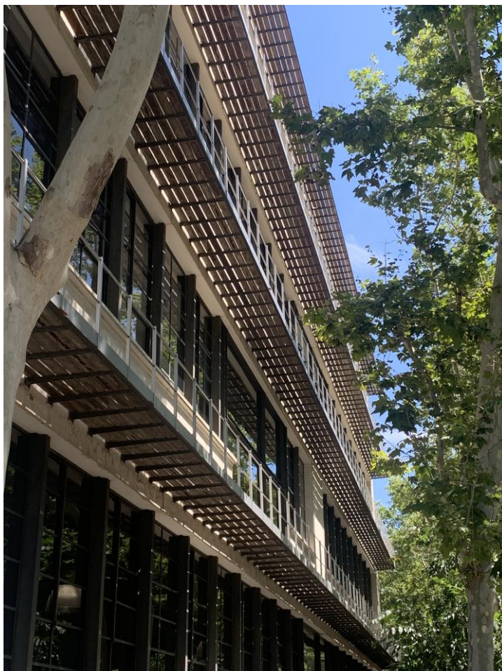
IMATGE 3 → VISTA PARCIAL DE LA FAÇANA A CARRER PERÚ
