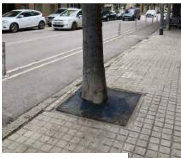
Detall soca i paviment arbre núm.10
