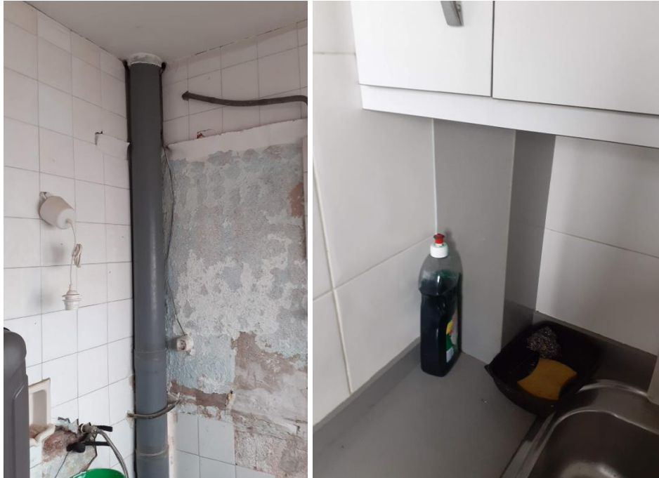
Imatge 9 Exemple de baixant vertical vist 5é4a i ocult en un calaix 4t1a
