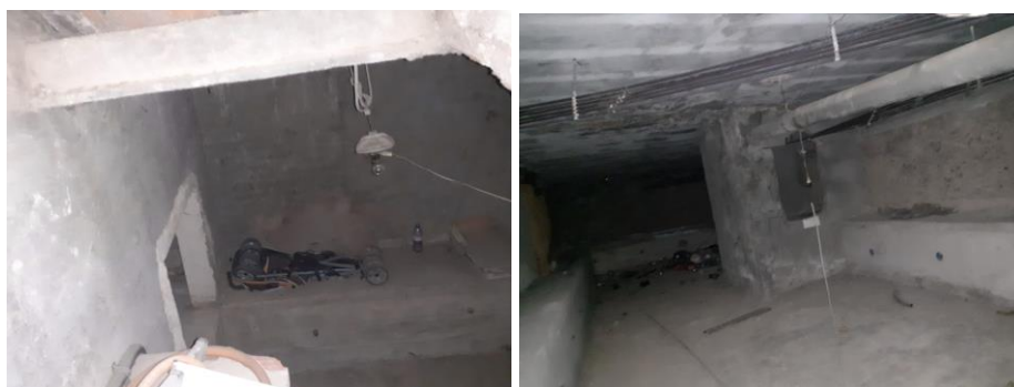
Imatge 4 Vista de l'accés a la cambra sanitària i vista de la cambra sanitària
