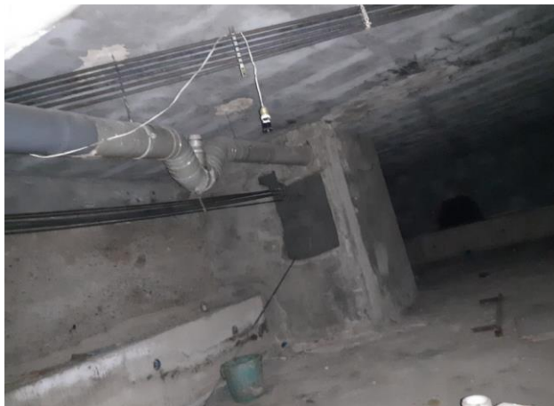
Imatge 10 Vista de la xarxa horitzontal de PVC per cambra sanitària
