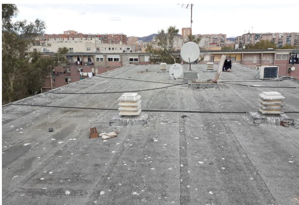
Imatge 8 Vista de la coberta
