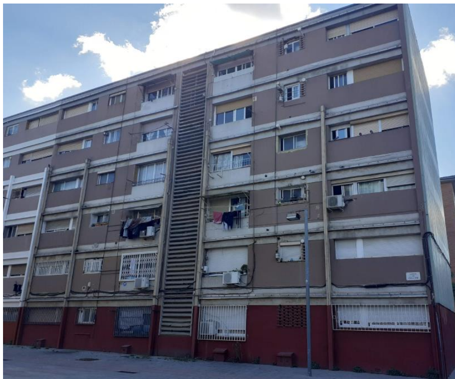
Imatge 2 Vista de la façana posterior
