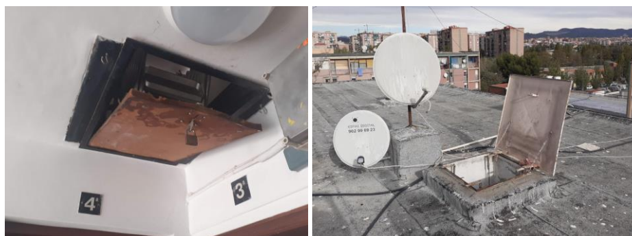
Imatge 7 Vista de la trepa.
