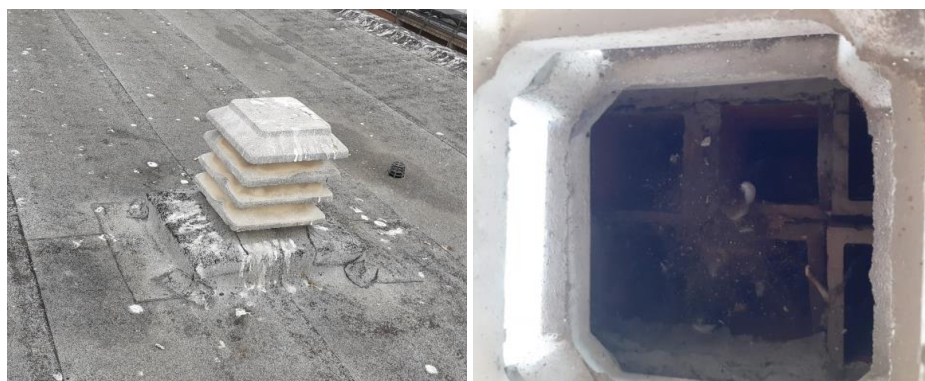
Imatge 12 Vista de les xemeneies d'extracció de les cuines.
