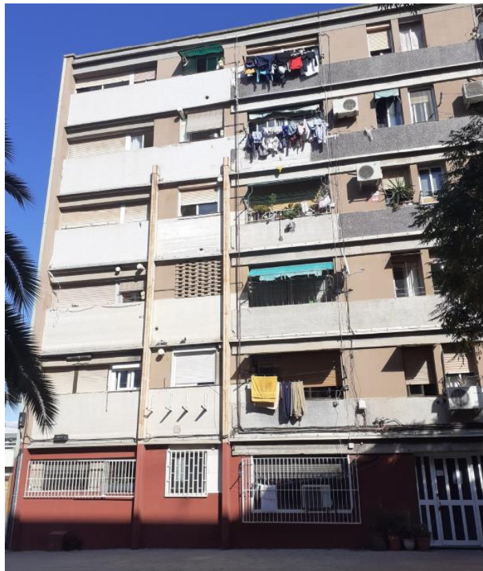
Imatge 1 Vista de la façana principal
