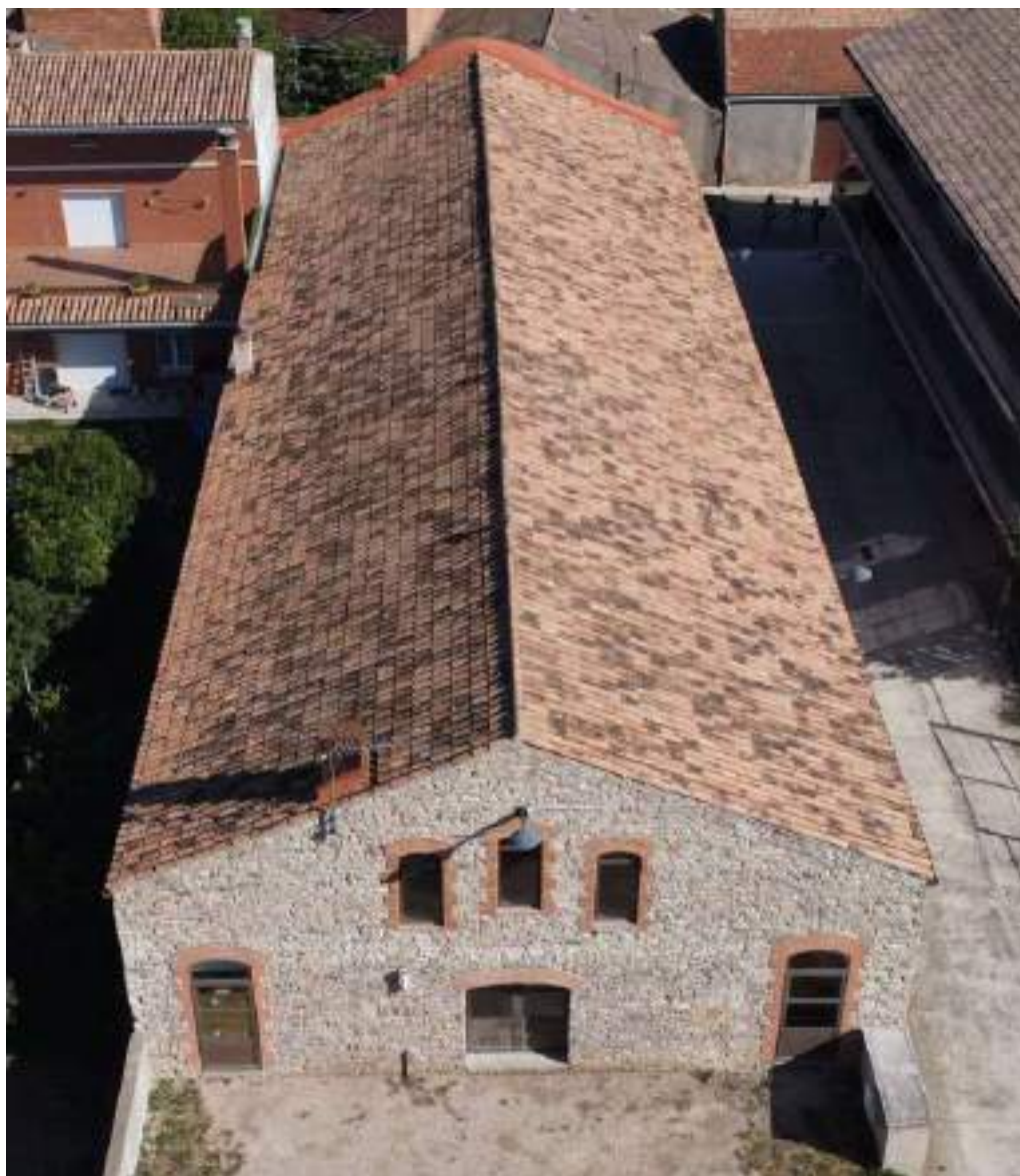
Coberta des de vista aèria
