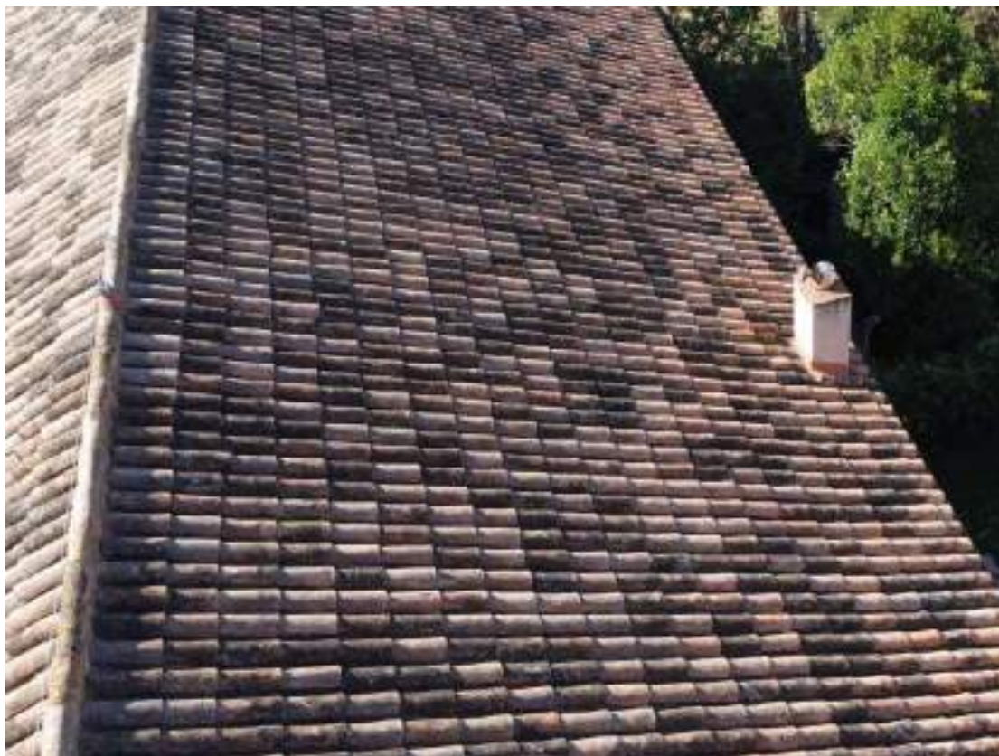
Coberta amb línia vida existent
