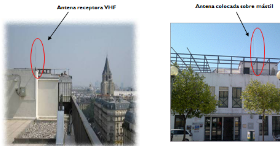
Exemples d'instal·lacions d'antenes
