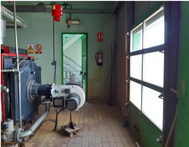
Accessos a la sala.
