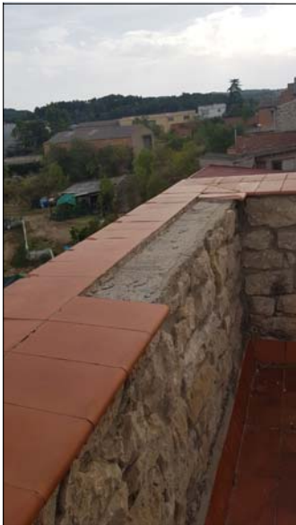
TERRAT PLA: VISTA PARCIAL I DETALLS DE LES BARANES I PECES DE REMAT
