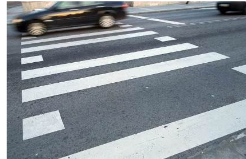
Figura 83. Pas de peatons amb reducció de pintura.
