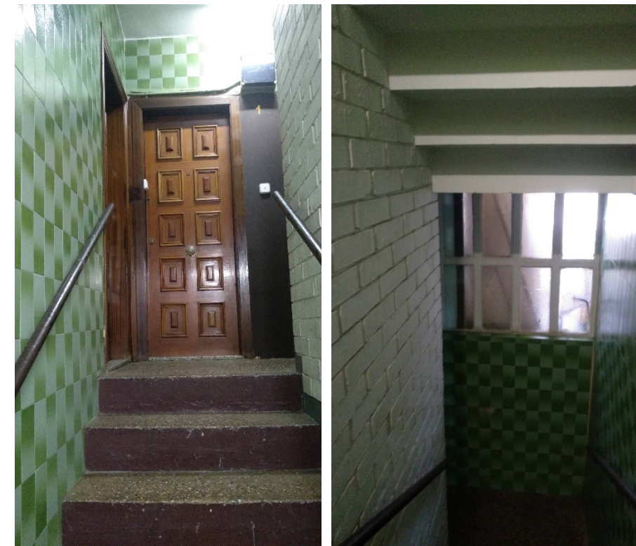
Imatge 12-13. Vista de Escala i finestres dels replans.
