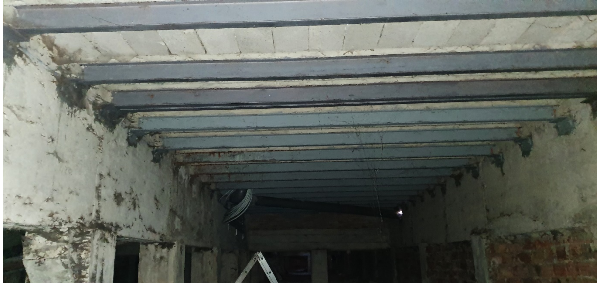
Imatge 9. Vista de reforços existents en cambra sanitària.
