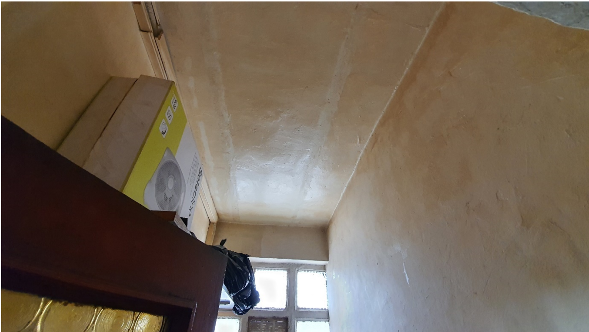
Imatge 19. Vista interior del pati de la façana del c/ Epir, privatitzat per part dels propietaris.
