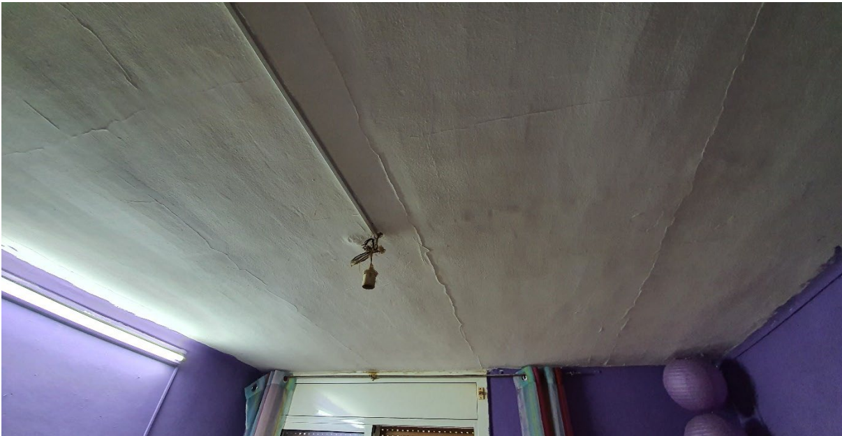
Imatge 6. Vista on apareix marcada l'estructura horitzontal de sostre unidireccional de biguetes de formigó. L'alçària entre plantes és de ~2,50 m.
