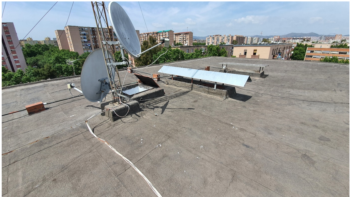
Imatge 14. Vista parcial de la coberta.
