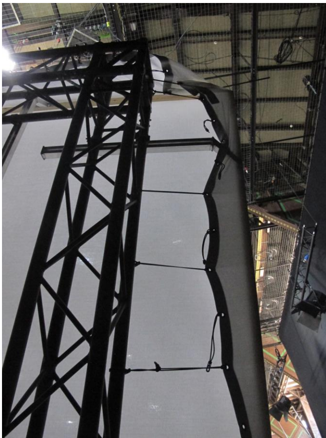
Tul fixat al truss amb gomes elàstiques.
