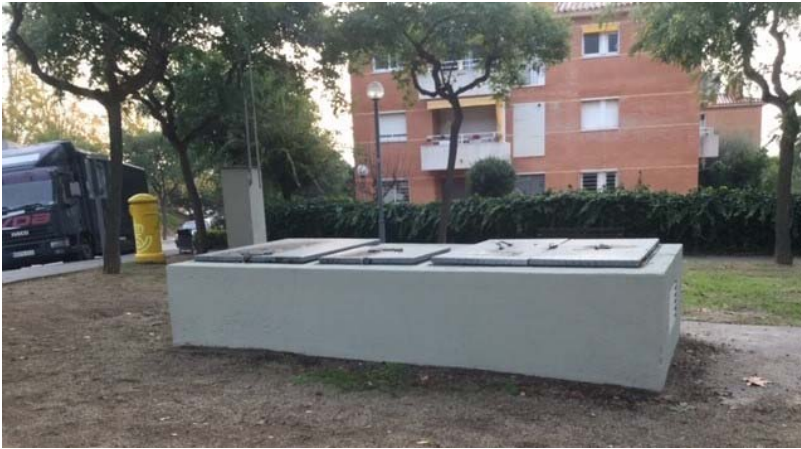
Captació Can Vilà
