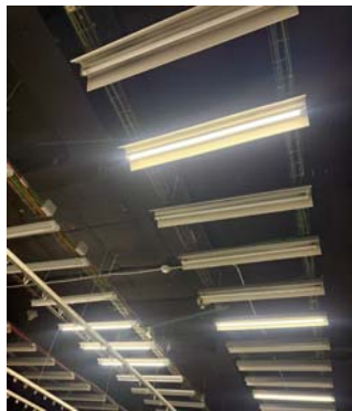
FOTOGRAFIA EXEMPLE INSTAL·LACIONS VISTES AMB REJIBAND I SOSTRE PINTAT NEGRE
