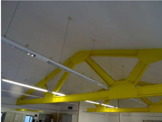
Encavallades de formigó existents
