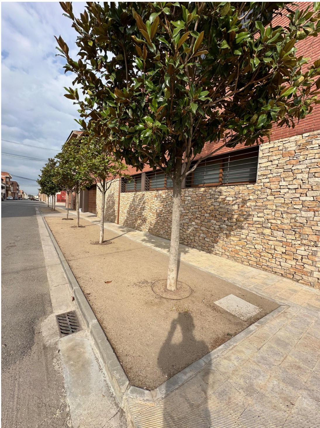
Imatge de parterre de sauló a executar
