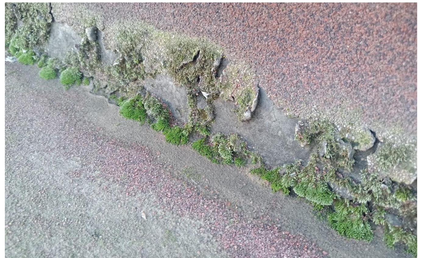
Desintegració de la làmina superior en les trobades amb l'ampit de coberta
