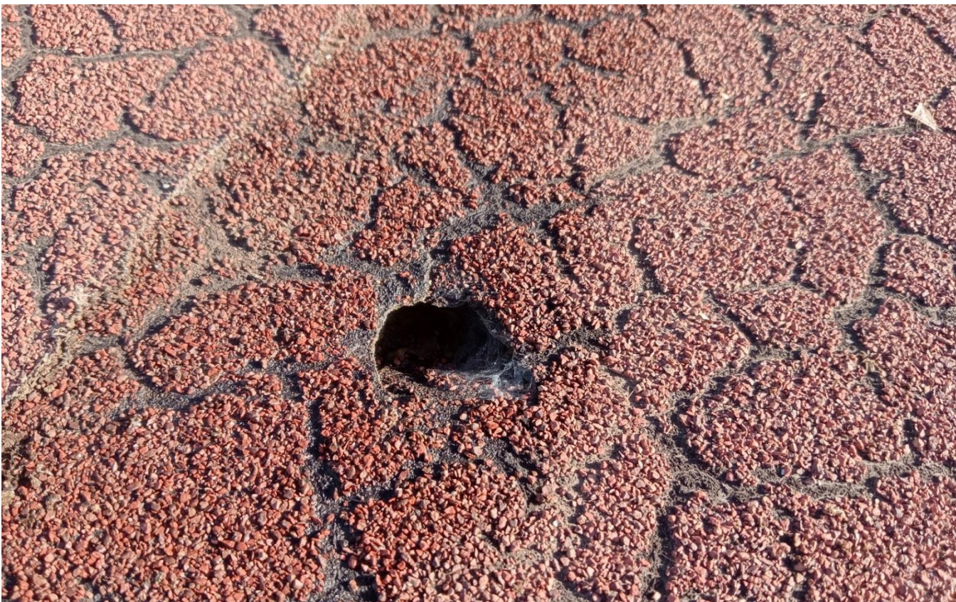
Punxonament de la impermeabilització.
