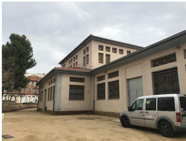
Façana espai verd, annex oest
