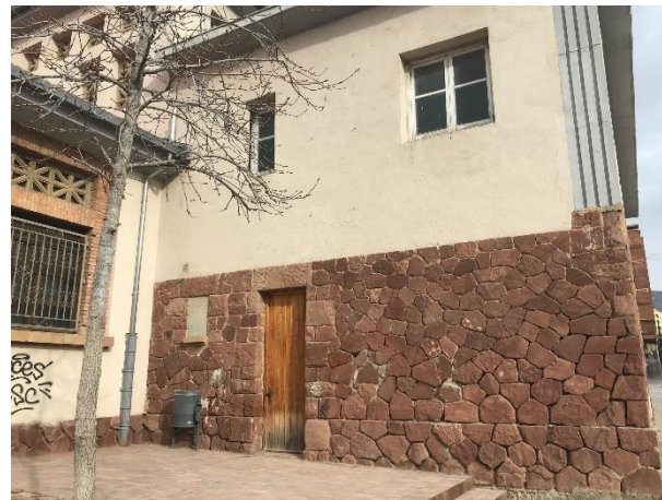
Vista exterior façana sud amb finestres tapiades
