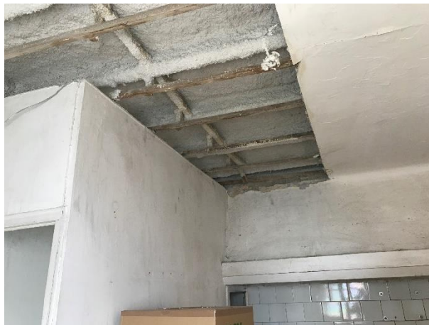
Vista interior bigues vistes i ignifugades
