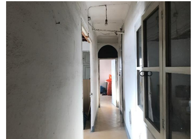
Vista interior espai distribuïdor, planta primera
