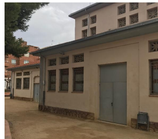
Vista general canaló i baixants vista
