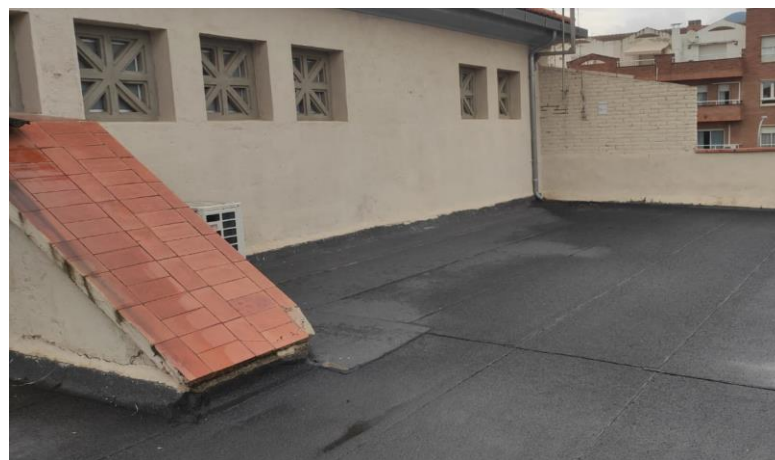
Coberta plana annex est
