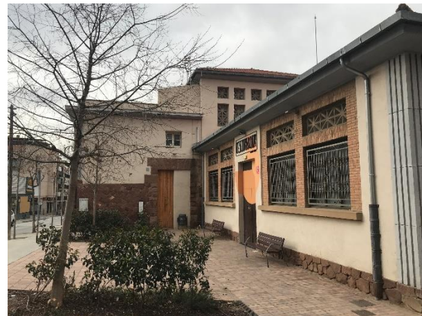
Façana c. Mossèn cinto Verdaguer, annex est
