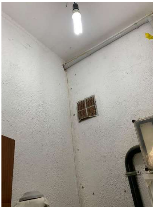
Il·lustració 11 Ubicació inversor fotovoltaic
