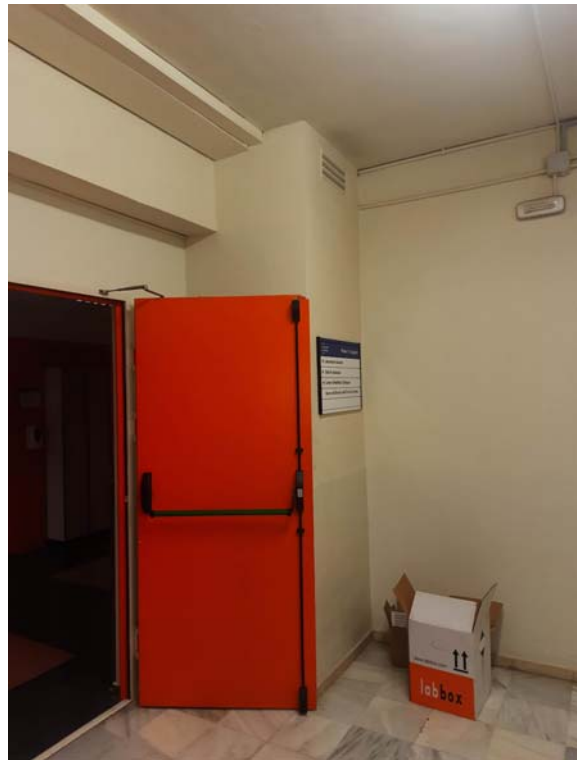
Detall muntant registrable per el que es conduiran els tubs fins a la planta tercera
