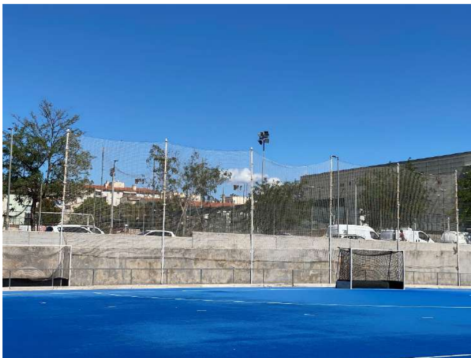
Sustitución y ampliación de la malla de fibra textil del sistema de detención de pelotas (h:8m) (Actuación A)
