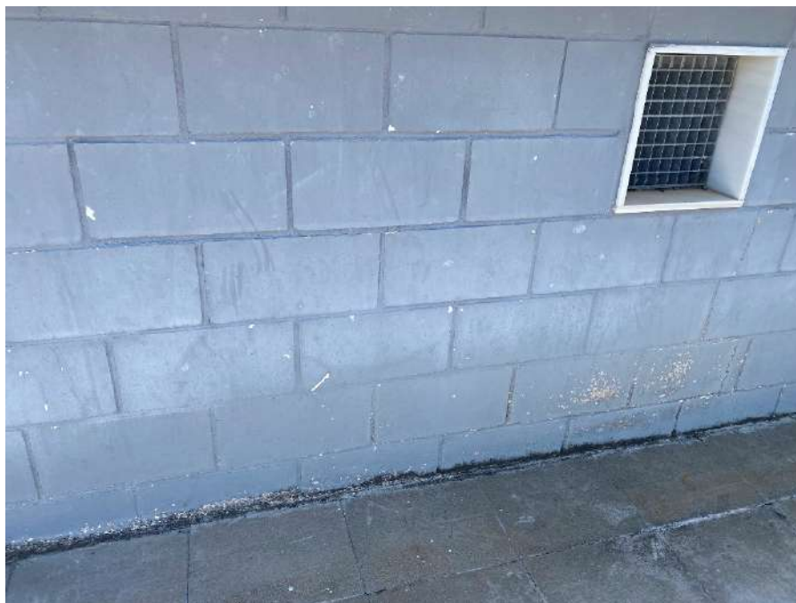
Impermeabilización de zócalo en la base de la grada principal para evitar humedades existentes en el interior de los espacios de paso bajo grada. (Actuación E)
