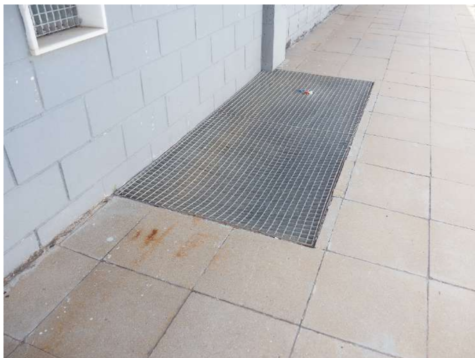
Sustitución relliga metálica ventilación sala técnica (Actuación E)
