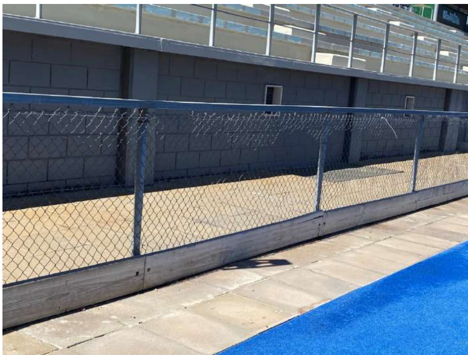
Sustitución malla simple torsión valla campo (h:1m) (Actuación A)
