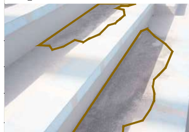
C.1_ FILTRACIONES EN GRADAS
