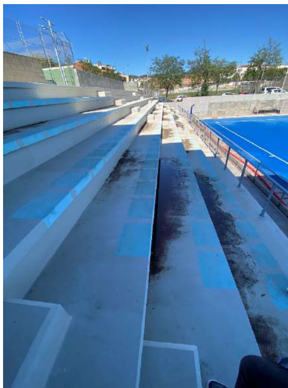
Reparación de filtraciones de agua en zona de gradas descubiertas (Actuación C)
