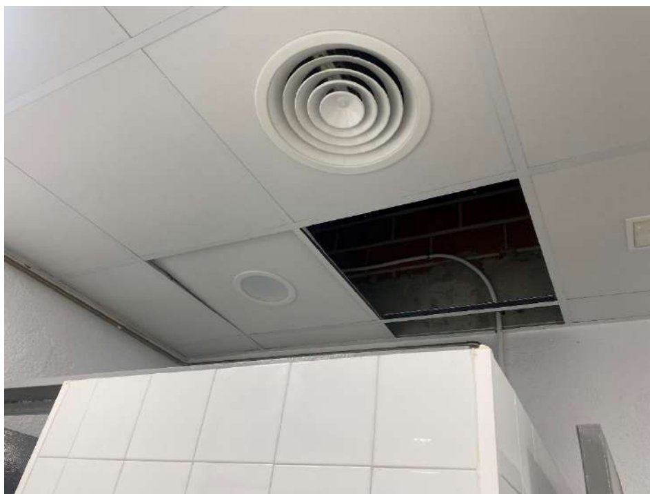
Sustitución falsos techos zonas vestuarios y zonas administrativas, colocación de aislamiento y renovación luinarías (Actuación D)
