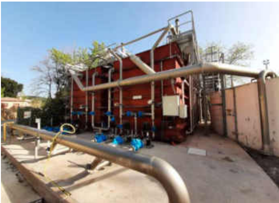
Imatge 1: Bombes d'aigua exteriors.
