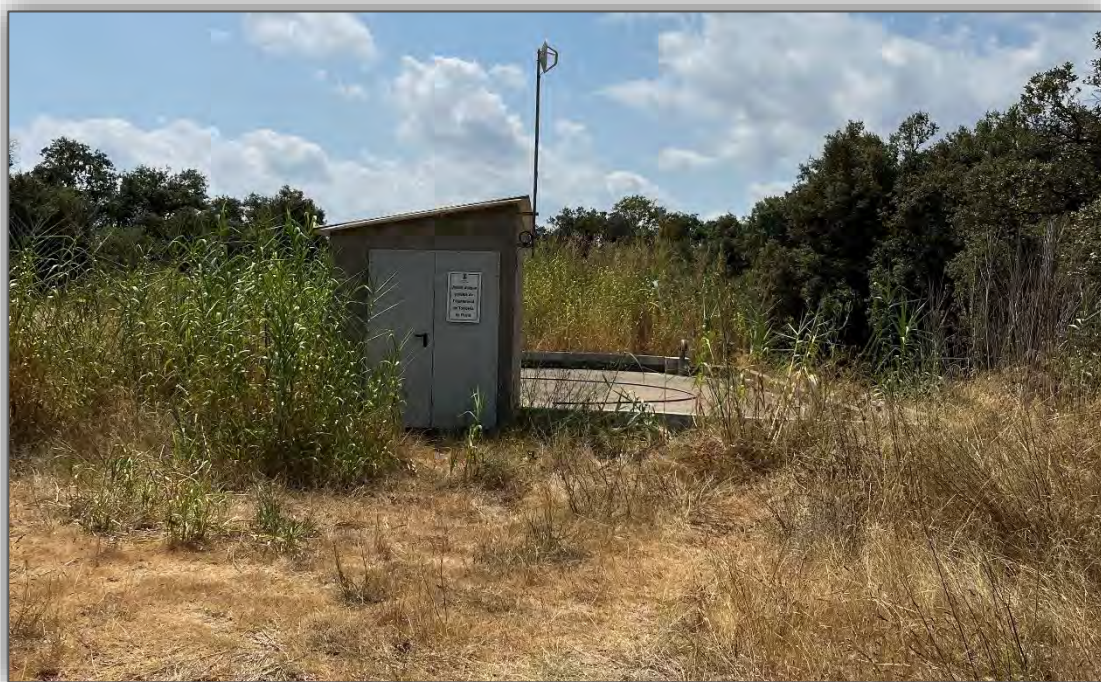
Foto. 4 – Dipòsit i caseta de Sant Tomàs de Fluvià.
