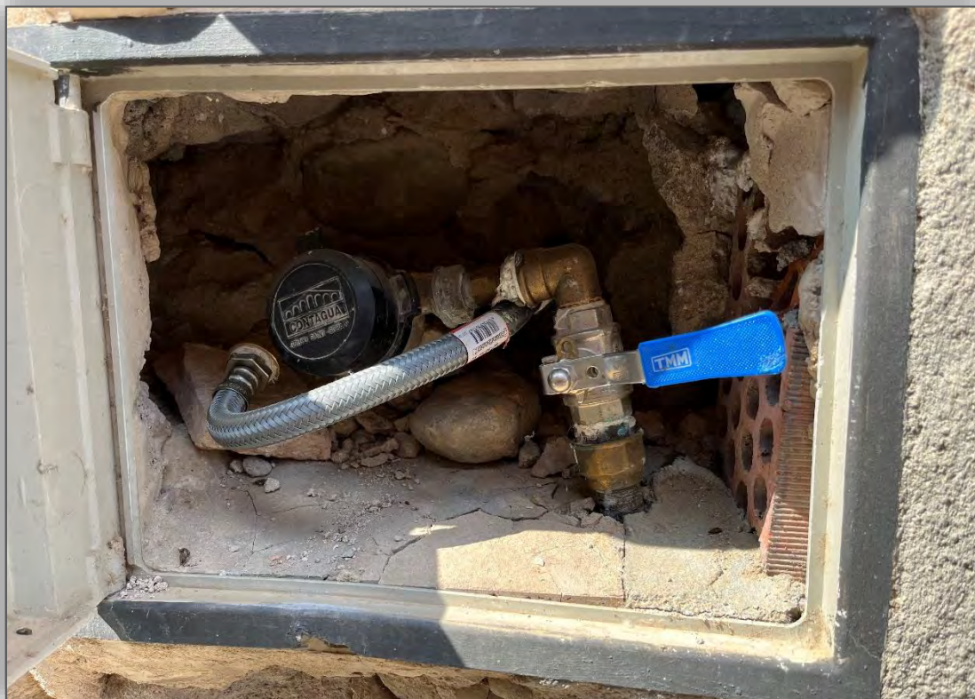
Foto. 3 – Mostra d'armari de comptador de Torroella de Fluvià.
