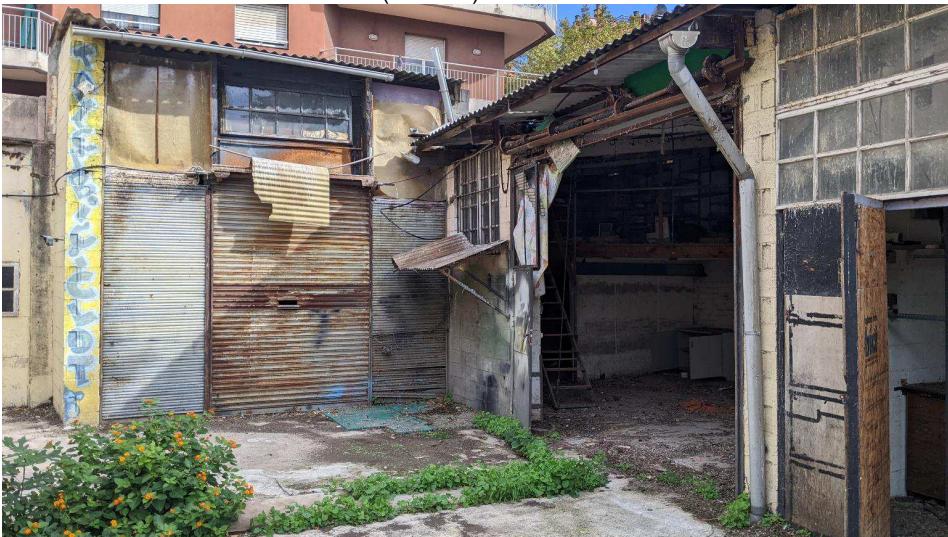
1.11 Fotografies estat actual. Construcció annexa a enderrocar (Annex 2)
