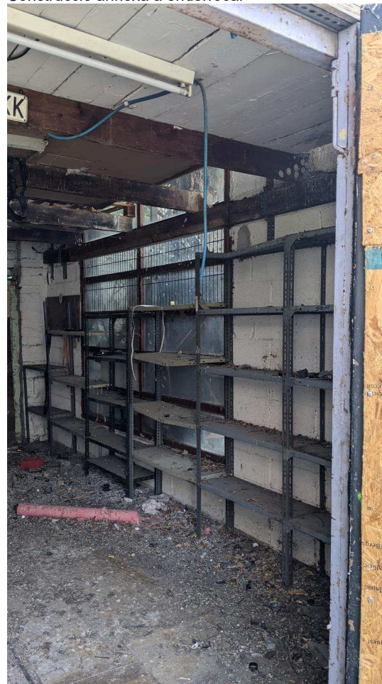
Construcció annexa a enderrocar
