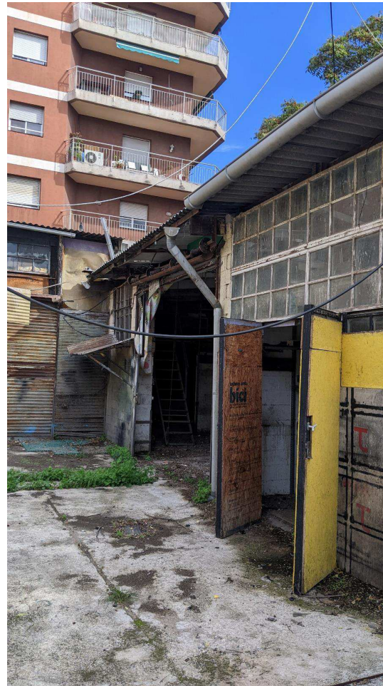
Construcció annexa a enderrocar
