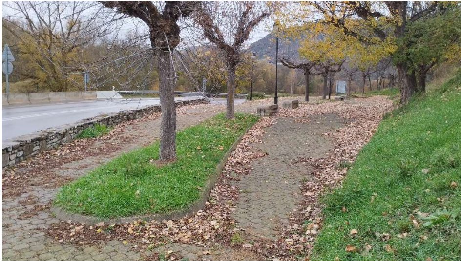
Zona del pou d'atac del pas sota la carretera N-260 per perforació horitzontal (marge dret de la ctra.)
