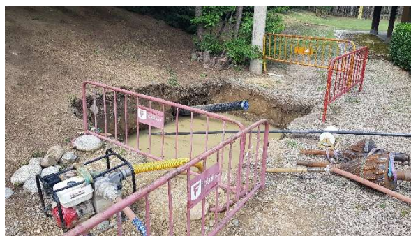
Pou de recepció de la perforació horitzontal dirigida.
