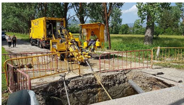
Pou d'atac de la perforació horitzontal dirigida.
