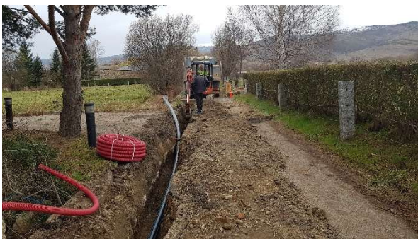
Obertura de rasa amb retroexcavadora.
