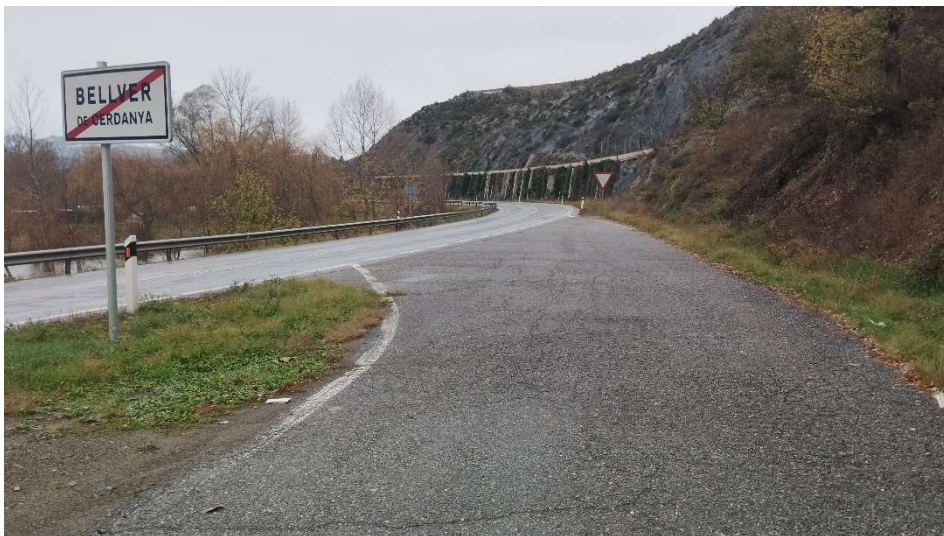
Final del carrer del Pirineus (mirant a ponent) on s'ha de connectar a la canonada existent cap el polígon industrial "pla de Codina"
