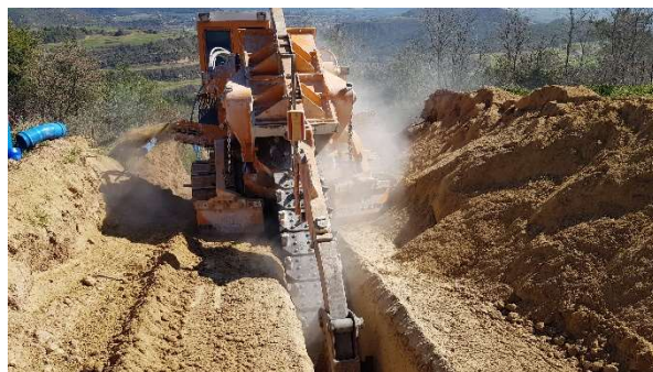
Obertura de rasa amb rasadora de cadenes.
