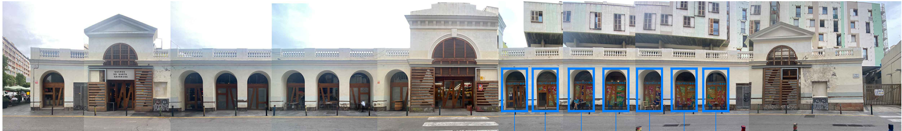
FAÇANA CARRER DE LES FREIXURES
