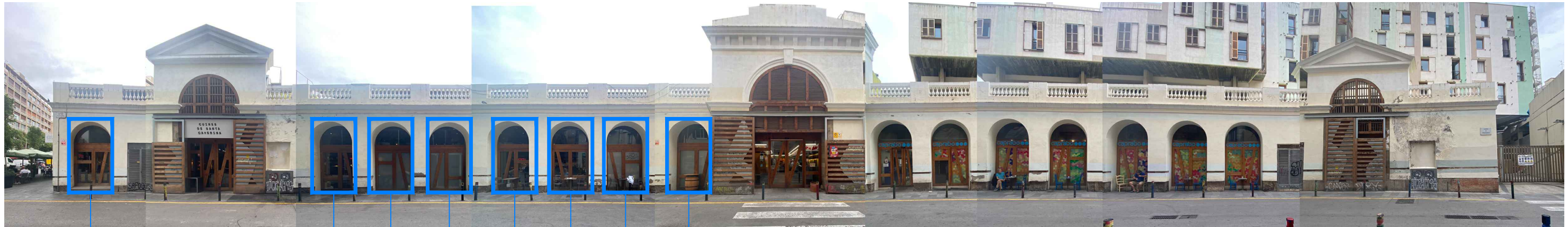
FAÇANA CARRER DE LES FREIXURES
