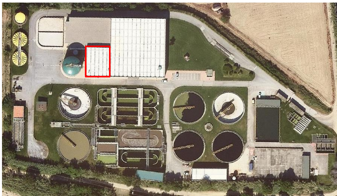
Figura 2. Ubicació de les calderes dins del recinte de l'EDAR de Blanes.
