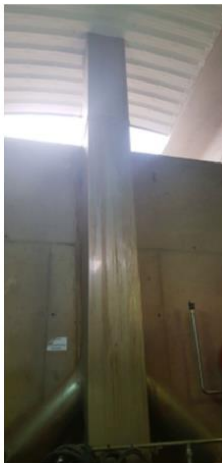
Figures 4 i 5. Xemeneia existent per a l'extracció de fums.
