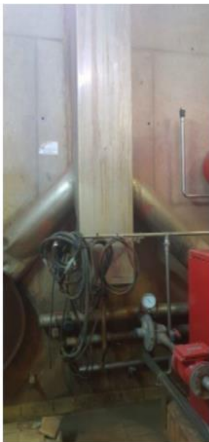
Figures 4 i 5. Xemeneia existent per a l'extracció de fums.
