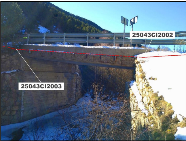
SITUACIÓ DEL TUB METÀL·LIC VISTA GENERAL
