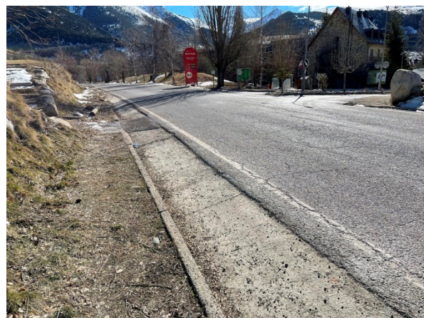
Fig.1.1.1.1.a. Inici de l'obra, pericó projectat 25043PE2362.
