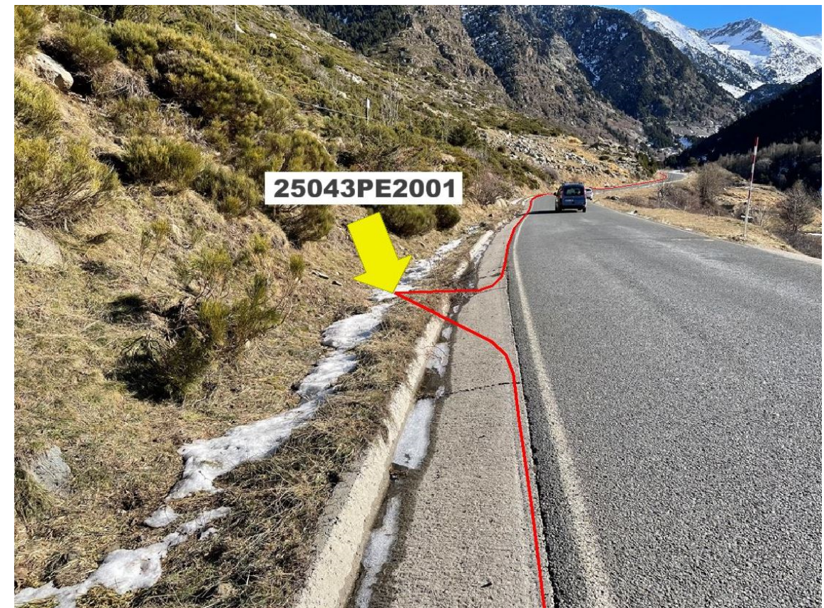
Fig 1.2.4.2.4. Ubicació del nou pericó 25043PE2001.
