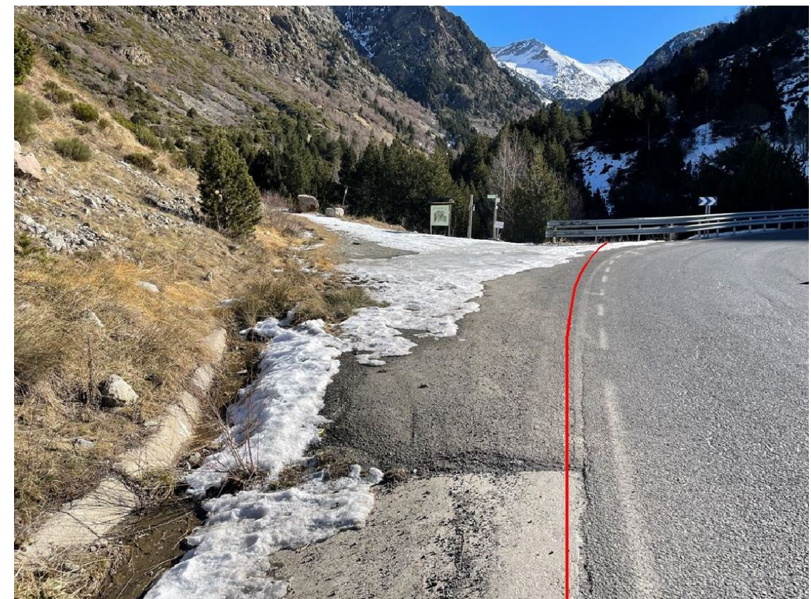
Fig 1.2.4.2.5. Tram d'obra civil entre 25043PE2001 i 25043PE2002.
