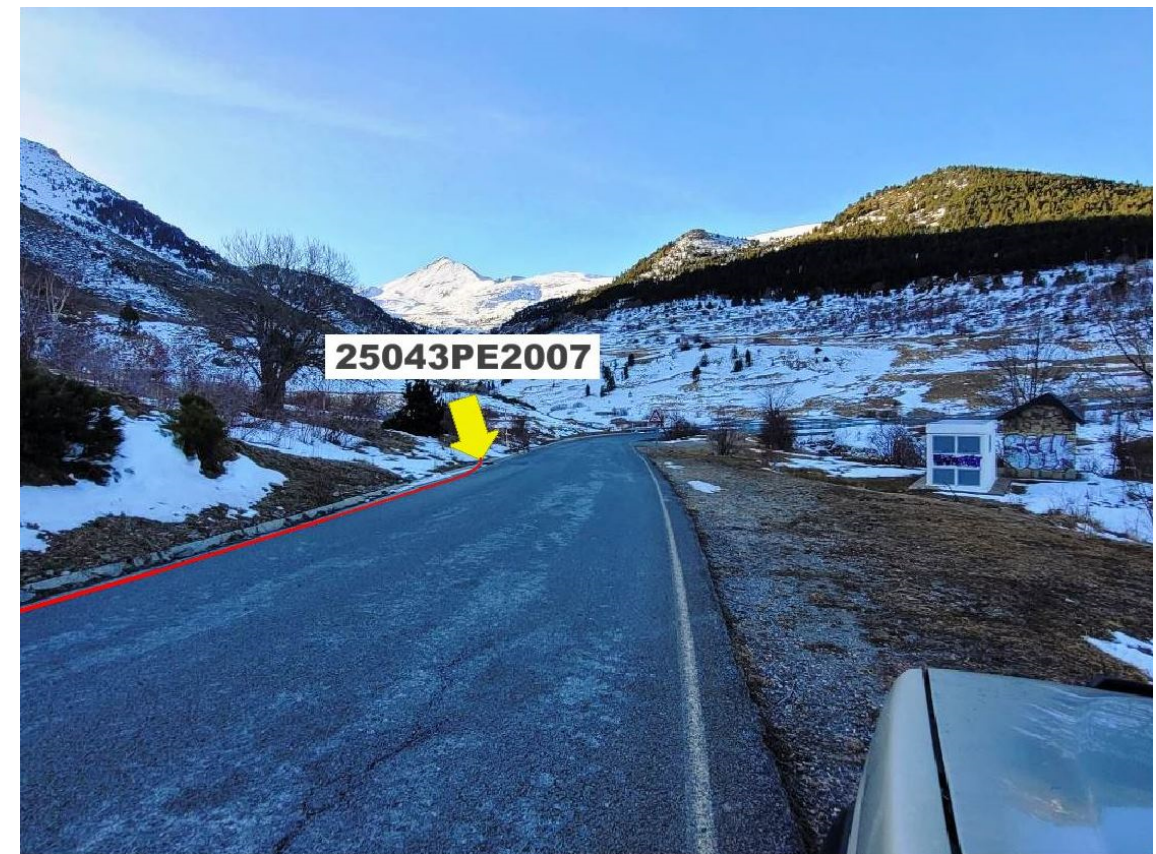
Fig 1.2.4.2.17. Ubicació nou pericó 25043PE2007. Punt final de l'obra civil.
