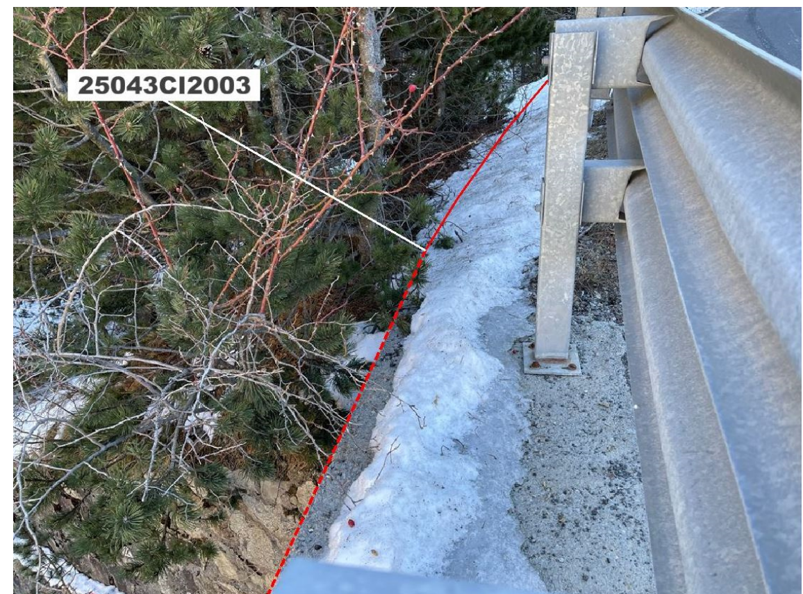
Fig 1.2.4.2.9. Canvi d'infraestructura de tub metàl·lic a canalitzat.
