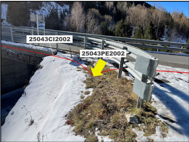
INICI PONT SOBRE EL RIU SANT MARTÍ
