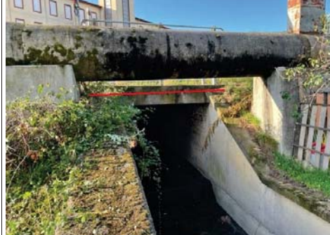
Pas pel pont de sobre el Torrent de la Verneda, amb tub metàl·lic, a la carretera N-141e PK 100+020
