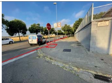
Micro-rasa tipologia ST-8, a l'Av de la Pau cantonada C/ Dr. Ferran, amb pericó tipus B2, a la vorera (17155PE2404)
