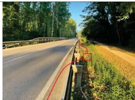
Pericó tipus A, a terres (17020PE2429) a l'entrada del pont del Torrent d'en Ribera a la carretera N-141e PK 105+455
