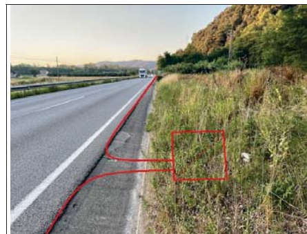
Micro-rasa tipologia ST2a, a la carretera N-141e PK 107+560, amb pericó tipus B2, a terres (17020PE2418)
