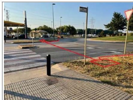
Pericó tipus B2, a vorera (17155PE2414) i sortida de la girola per l'Av de la pau amb tipologia ST-8 a rigola
