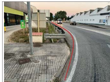
Tram Micro-rasa tipologia ST-1 a la carretera GI-535, entre el PK 0 i el PK 0+150
