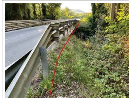
Pas pel pont de sobre la Sèquia de Bescanó, amb tub metàl·lic, a la carretera N-141e PK 106+720
