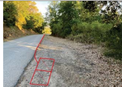
Micro-rasa tipologia ST3a, a la carretera de Vilanna PK 1+135, amb pericó tipus C2, a terres (17020PE2427)
