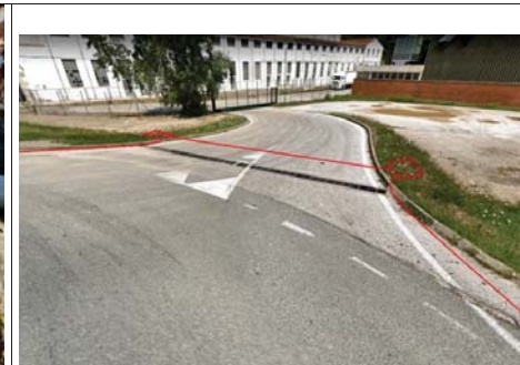
Pas pel pont de sobre la Riera de Sant Pere, amb tub metàl·lic, a la carretera N-141e PK 03+102
