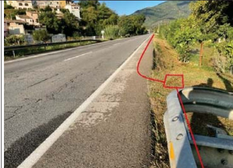
Micro-rasa tipologia ST-1, la sortida del pas del pont de la riera de St Amaç, amb pericó tipus A, a terres (17008PE2403)
