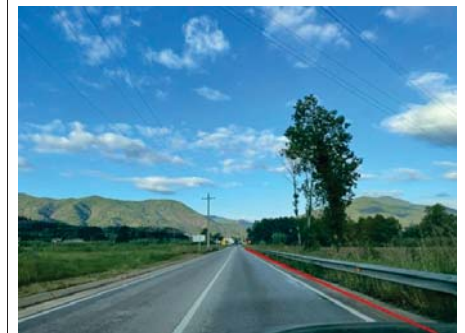
Micro-rasa tipologia ST1, a la carretera N-141e
