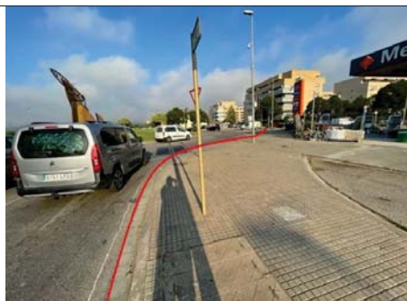
Micro-rasa tipologia ST-8 a l'entrada de la girola amb l'Av Marqués de Camps
