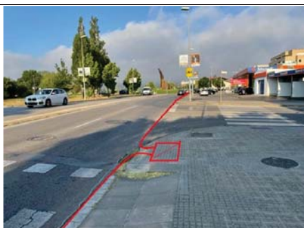
Micro-rasa tipologia ST-8, a l'Av de la Pau cantonada C/ Rafel Masó, amb pericó tipus B2, a la vorera (17155PE2416)
