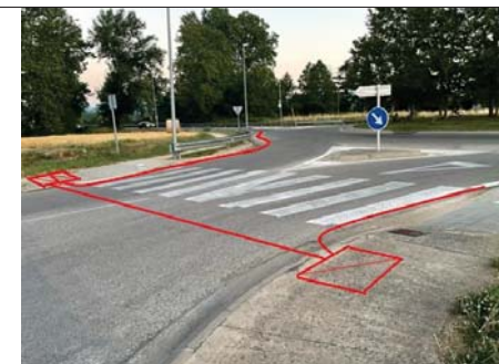
Creuament del C/ Ramurs a la girola de la N-141e amb la carretera de Montfullà, amb tipologia ST-7, des de el pericó tipus B2 17020PE2403 al pericó tipus C2 17020PE2404, situats a TERRES
