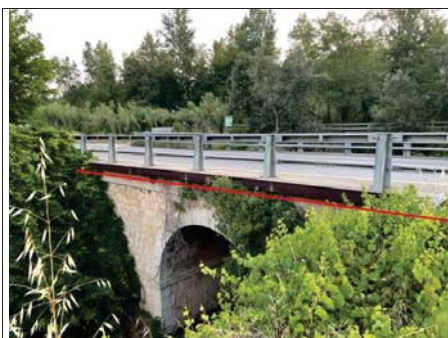
Pas pel pont de sobre la Sèquia de Bescanó, amb tub metàl·lic, a la carretera N-141e PK 108+370
