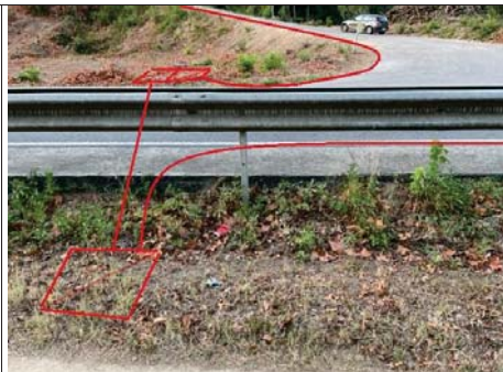
Creuament de la carretera N-141e PK 106+17, ST6, i Pericó tipus B2 a terres de la Via Verda (17020PE2421)
