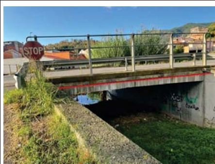
Pas pel pont de sobre la Riera de Sant Amaç, amb tub metàl·lic, a la carretera N-141e PK 100+470
