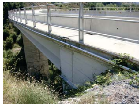
Exemple de tub metàl·lic instal·lat en un pont de la carretera C-16
