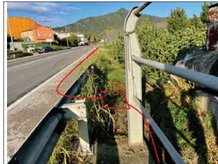
Micro-rasa tipologia ST-1, a la sortida del pas del pont del Torrent de la Verneda, amb pericó tipus A, a terres (17008PE2405)
