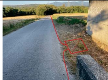
Micro-rasa tipologia ST-3a, a la carretera de Vilanna i pericó tipus B2 a terres (17020PE2426), al costat der l'Església de St. Mateu
