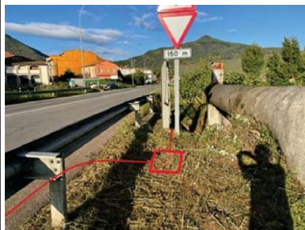
Micro-rasa tipologia ST-1, a l'entrada del pas del pont del Torrent de la Verneda, amb pericó tipus A, al voral (17008PE2404)
