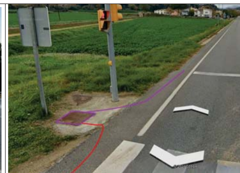
Micro-rasa tipologia ST1en l'enllaç amb la canalització existent no inventariada a la carretera N-141e PK 112+342, al pericó existent tipus B 17020PE2406
